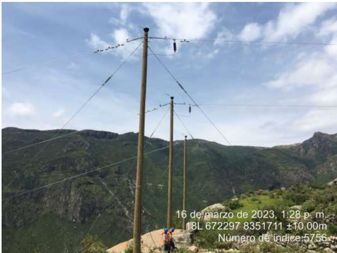
Figura 23: Fotografía de instalación de apartarrayos.
