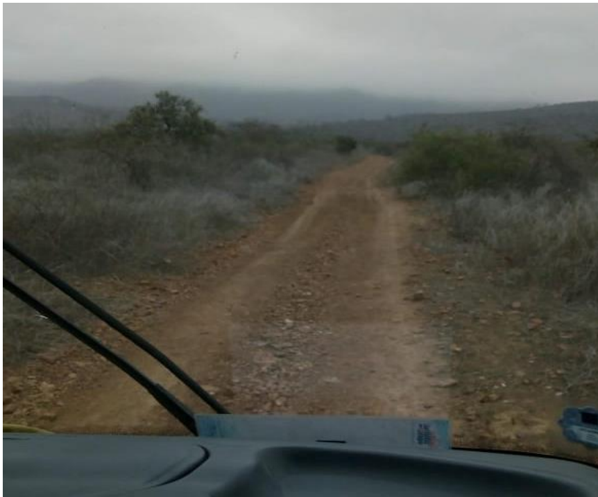
CARRETERA EN MAL ESTADO
