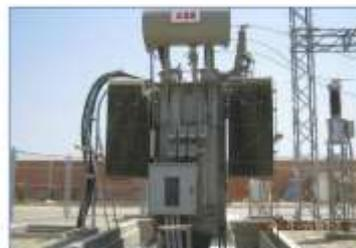
Transformador ABB de 42 MVA 60/13,8 kV
