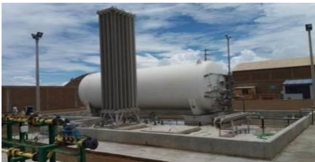
Figura 18: Estación de Servicio en el Distrito de Pacasmayo
