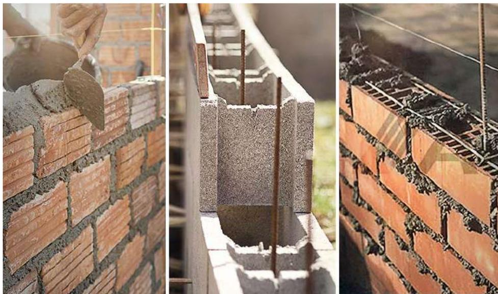
**Fig. 4.** Detalles de la albañilería reforzada o estructura [50].
