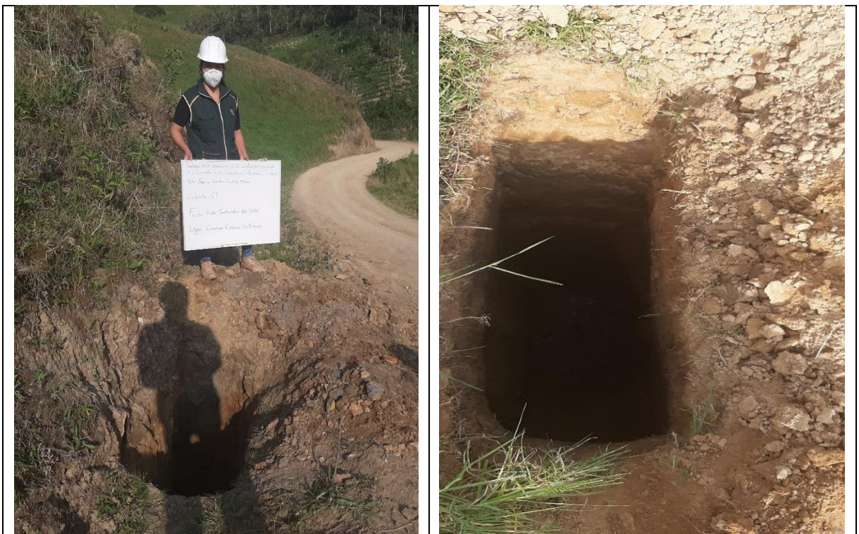
Figura 19: Excavación de calicata - C5 Fuente: Elaboración propia
