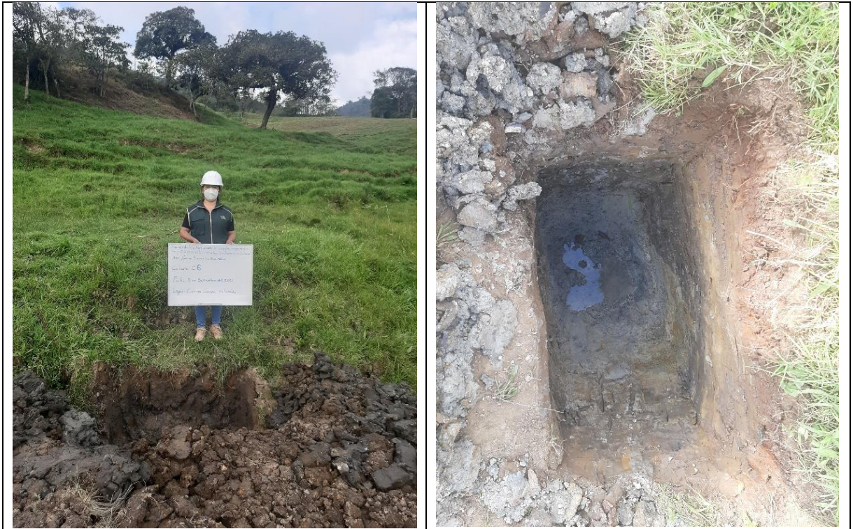
Figura : Excavación de calicata - C1 Fuente: Elaboración propia
