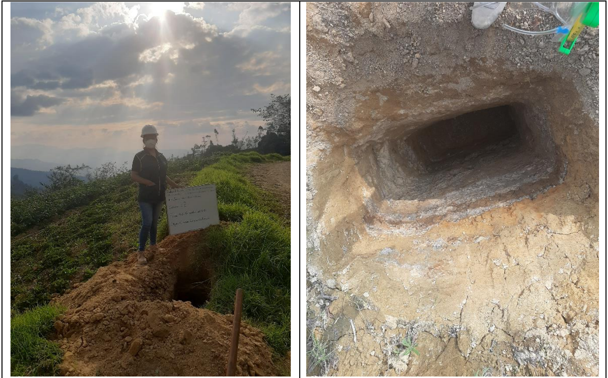
Figura 18: Excavación de calicata - C4 Fuente: Elaboración propia
