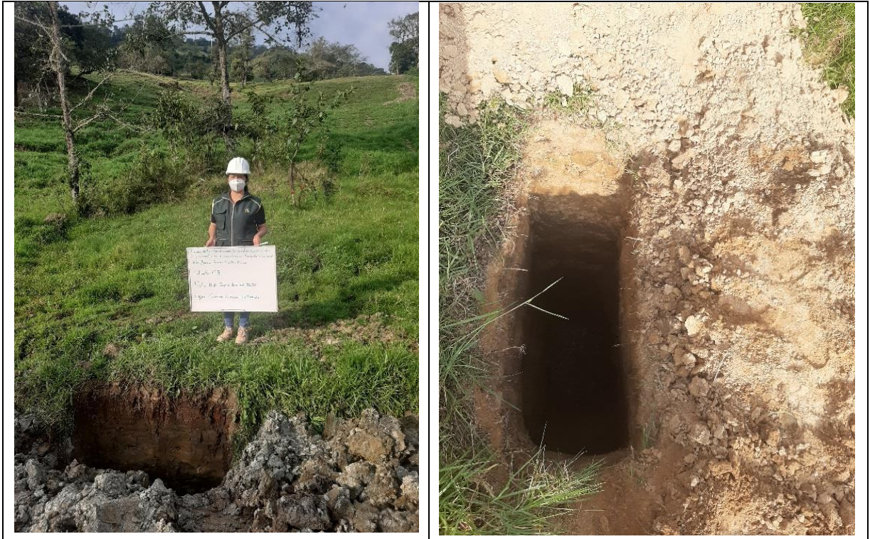
Figura : Excavación de calicata - C2 Fuente: Elaboración propia
