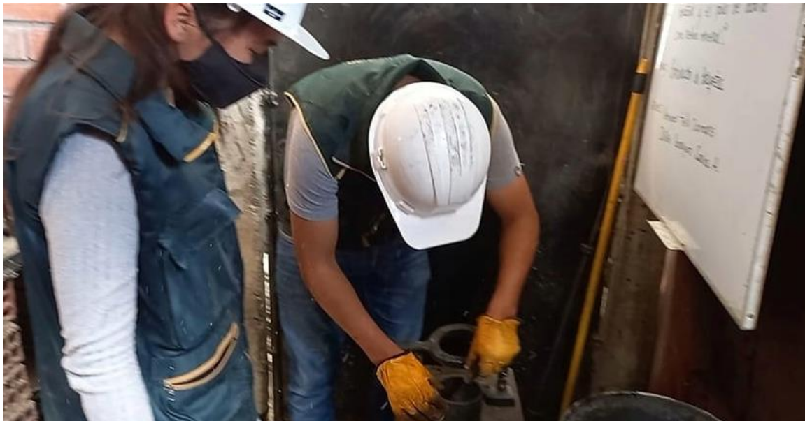
Fig. 84. 1º Aplicación del papel filtro para los moldes de las briquetas
