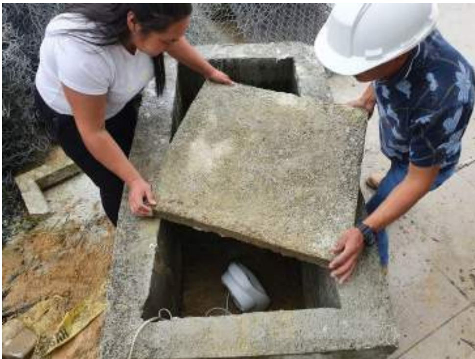
Anexo 2.22. Tapa que cubre los modelos a escala para el análisis de aislamiento térmico
