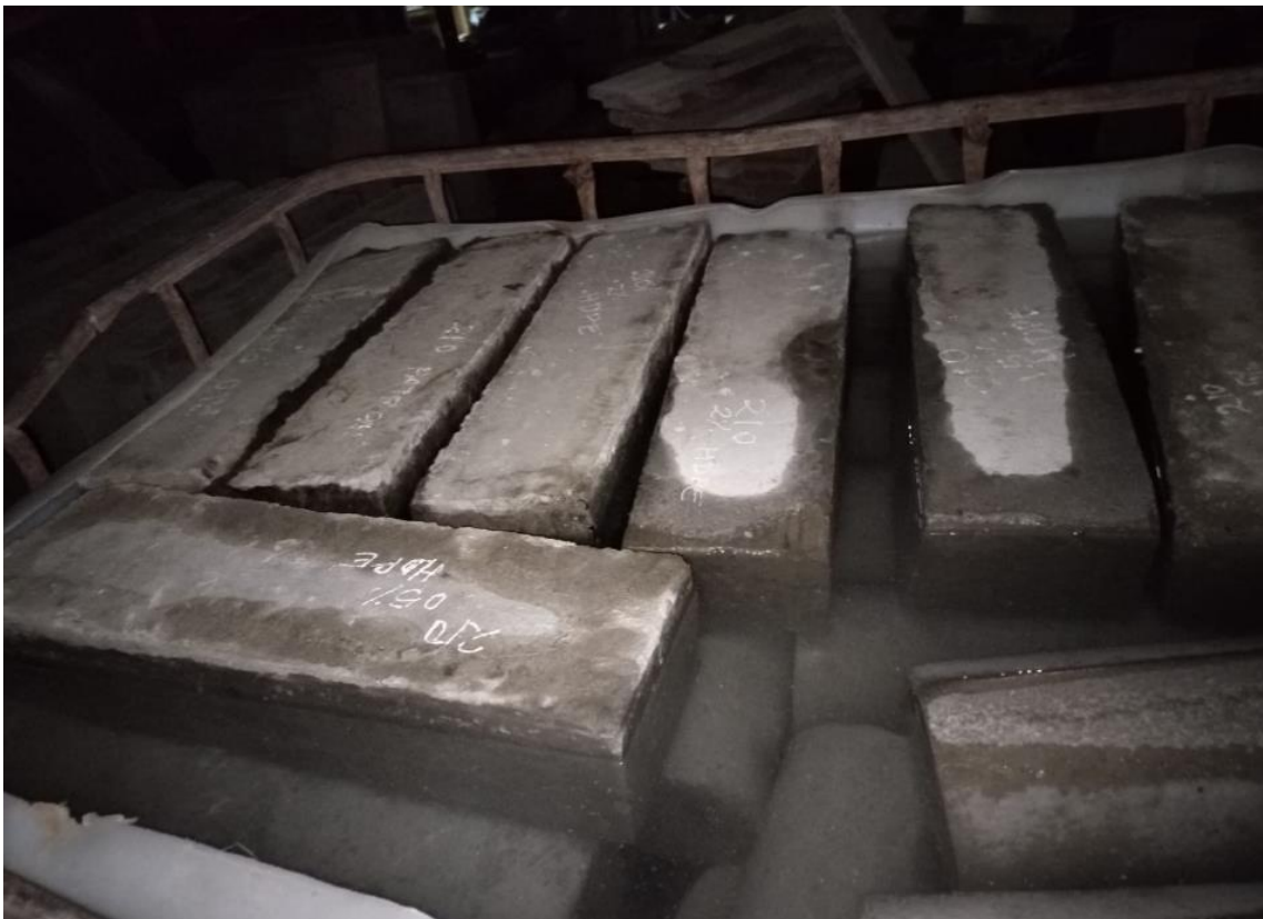
Evidencia 16: Curado de cilindros y vigas de concreto
