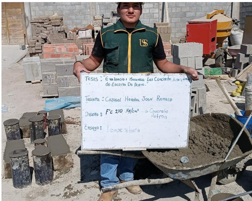
Evidencia 12: Ensayo de temperatura del concreto fresco
