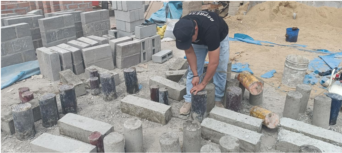
Evidencia 15: Desmoldado de los cilindros y vigas de concreto
