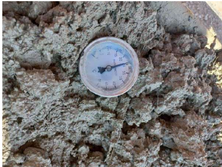
Fig.31. Medición de temperatura que presenta el concreto recién elaborado
