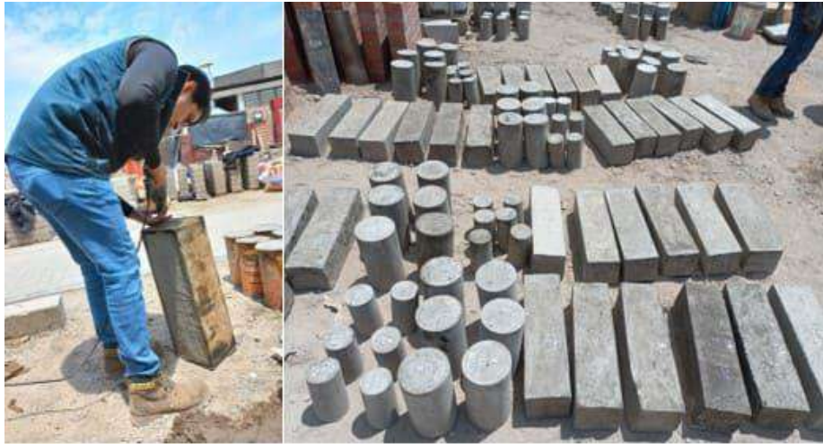
Fotografía 17. Desencofrado de los moldes de concreto
