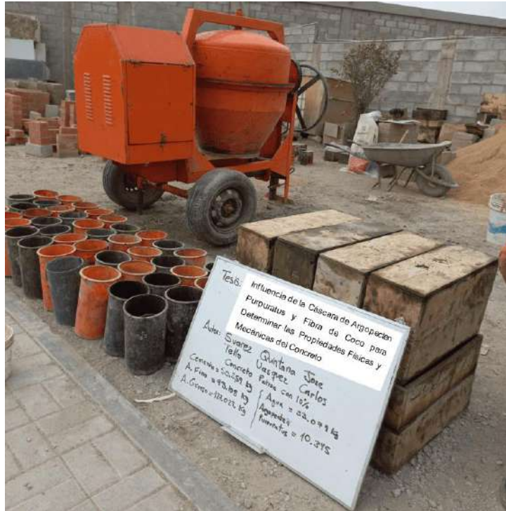
Fotografía 15. Preparación equipo y moldes a utilizar, previamente engrasado
