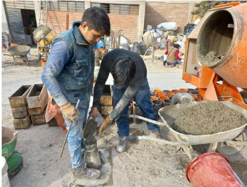
Fotografía 19. Asentamiento del concreto fresco
