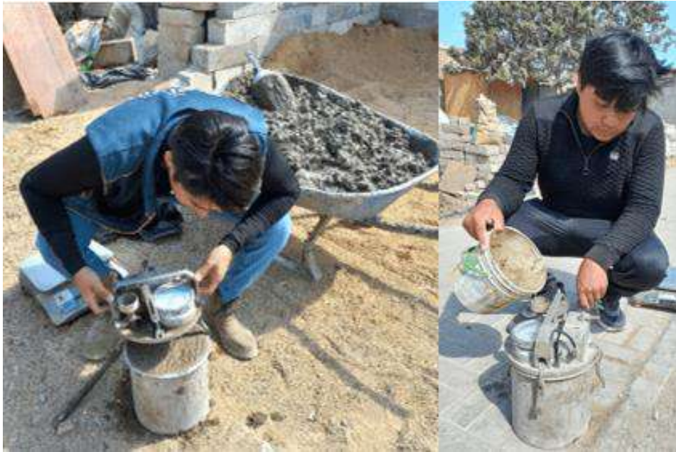
Fotografía 21. Contenido de Aire del concreto fresco
