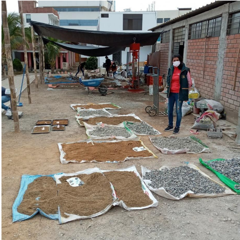
Fotografía 9. Agregados finos y gruesos para la realización de pruebas de laboratorio
