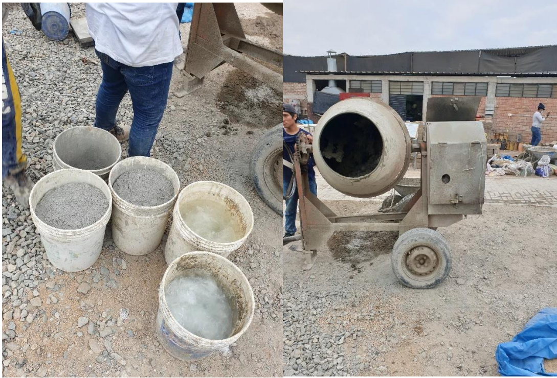
Fotografía 13. Diseño y elaboración de concreto experimental
