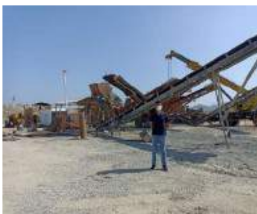
Fig. 1. Planta productora de asfalto
