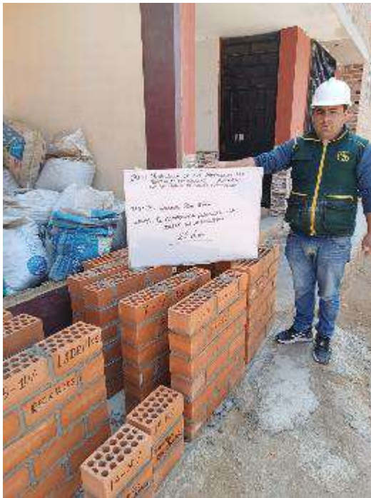
Elaboración de muretes de albañilería.
