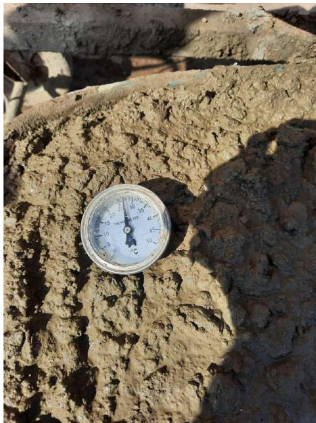
Fig. 11. Temperatura del concreto
