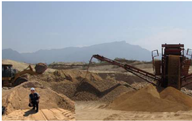
Fig. 2. Muestra de agregados en la cantera la victoria
