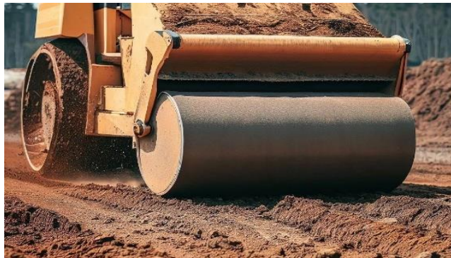
Fig. 6. Estabilización de suelos. [34]
