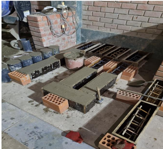
Fotografía 11. Vaciado del concreto a las vigas reforzadas con bambú y con acero
