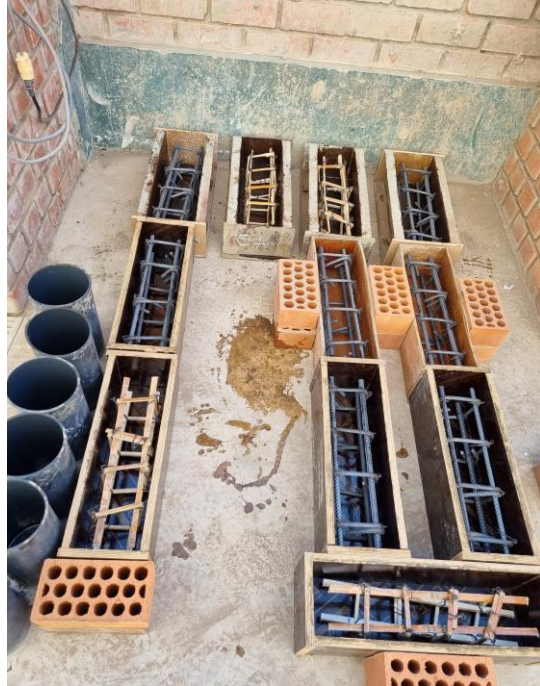
Fotografía 9. Encofrado de las vigas reforzadas con bambú y con acero Fuente: Propia
