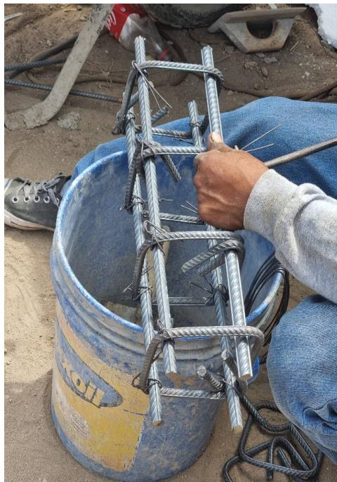
Fotografía 6. Armado estructural de la viga de acero
