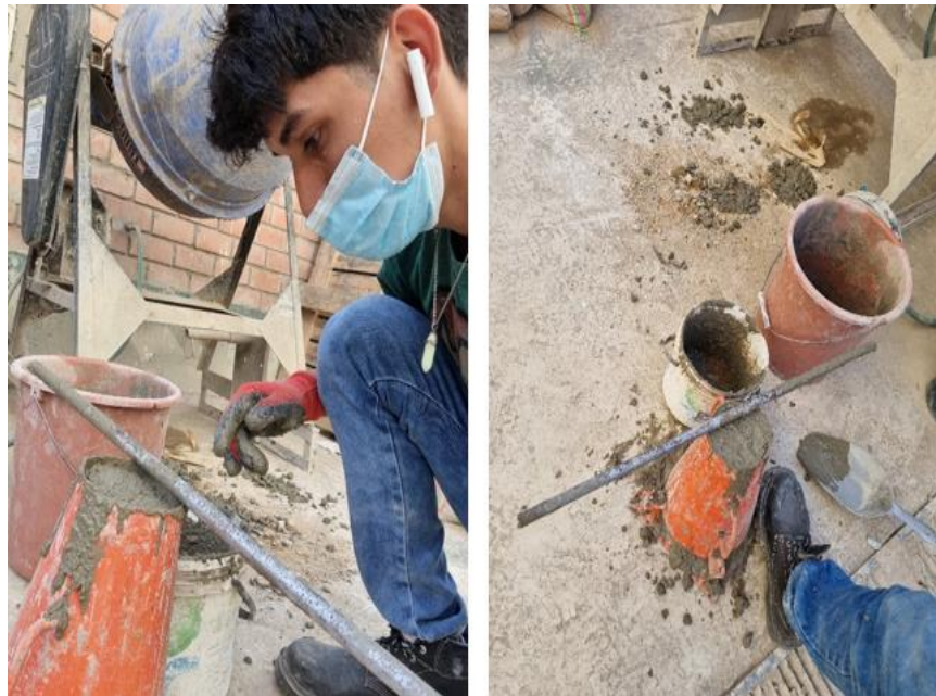
Fotografía 10. Vaciado del slump Fuente: Propia
