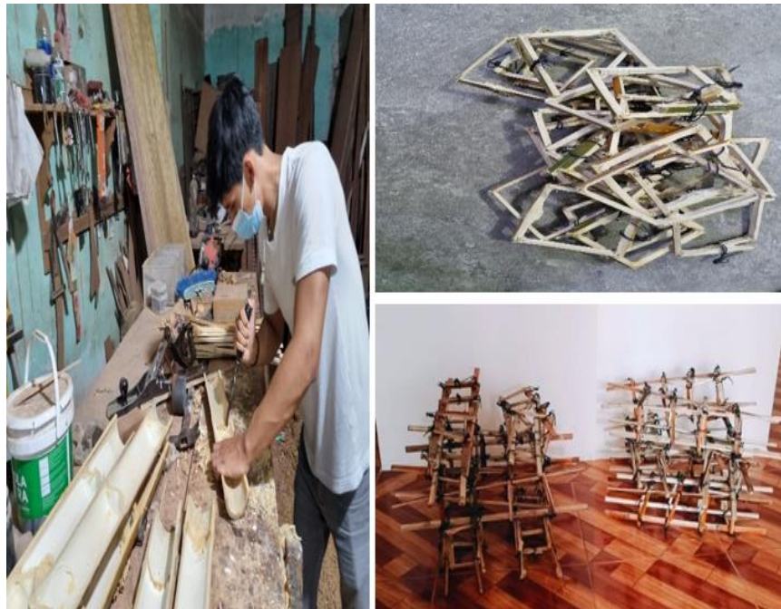
Fotografía 8. Armado estructural de la viga de bambú
