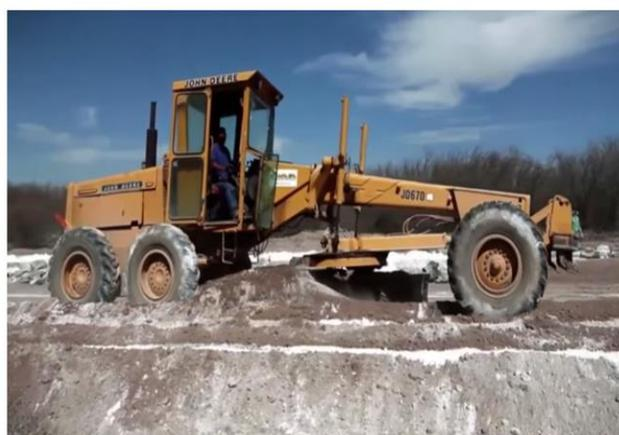
**Fig. 7.** Estabilización con cal [23].
