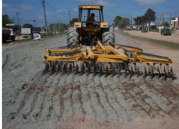
**Fig. 6.** Estabilización con cemento [22].
