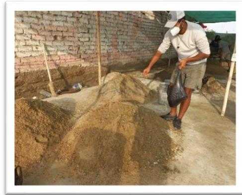
Nota: en esta figura se muestra el proceso de elaboración y el mezclado de cada uno de los materiales teniendo en cuenta el porcentaje de adición de limadura y escoria de acero, cada uno de estos procesos se tiene que hacer con mucho cuidado para no equivocarse en la mezcla
