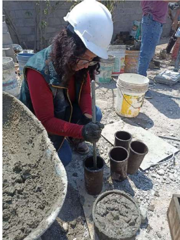
Fotografía 24 Vaciado de mezclas (4)
