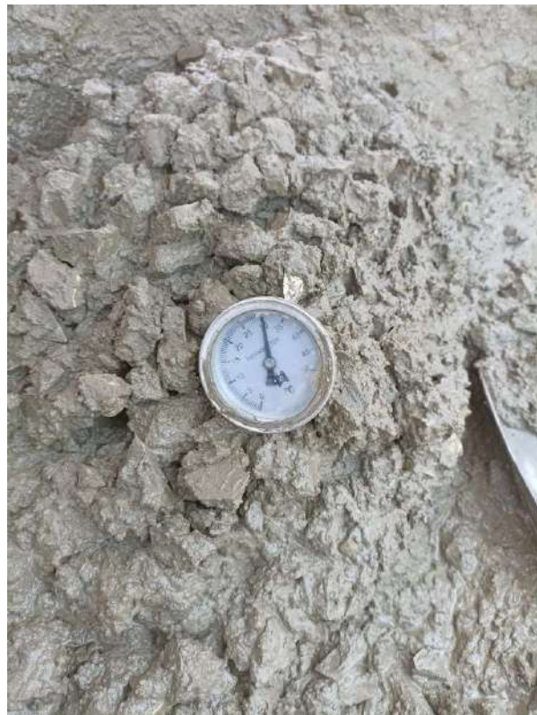
Fotografía 36 Ensayos de temperatura (2)
