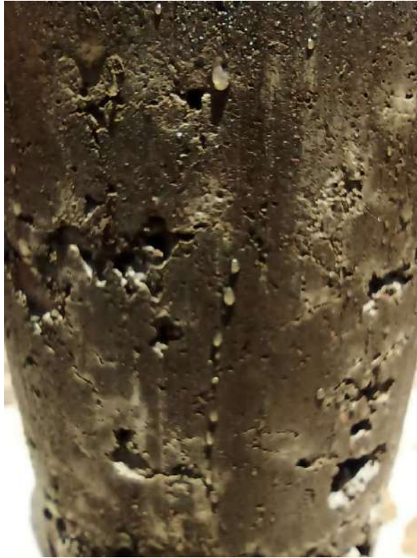
Fig. 15 Detalle de cangrejera en probeta con ladrillo
