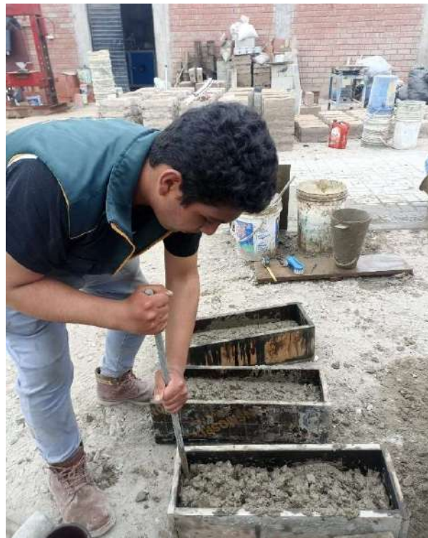
Fotografía 25 Vaciado de mezclas (4)
