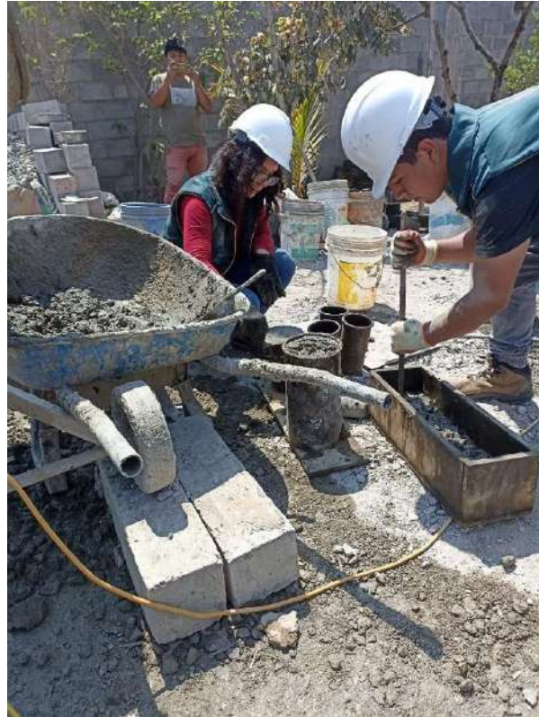
Fotografía 22 Vaciado de mezclas (2)
