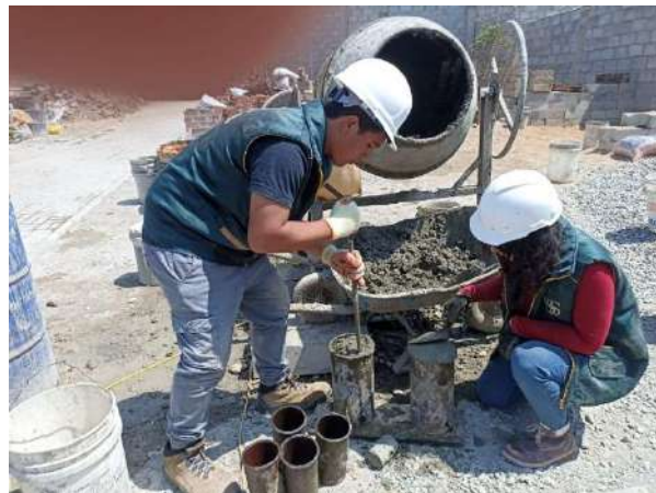
Fotografía 23 Vaciado de mezclas (3)
