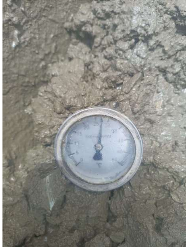
Fotografía 37 Ensayos de temperatura (3)
