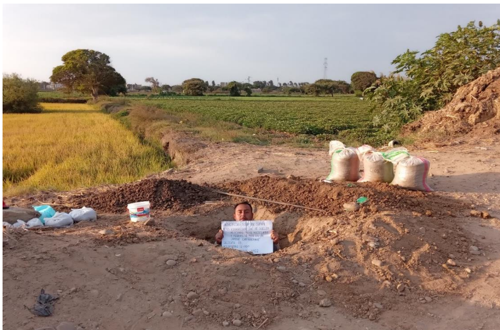
Fotografía 13 Verificación de la calicata 3.
