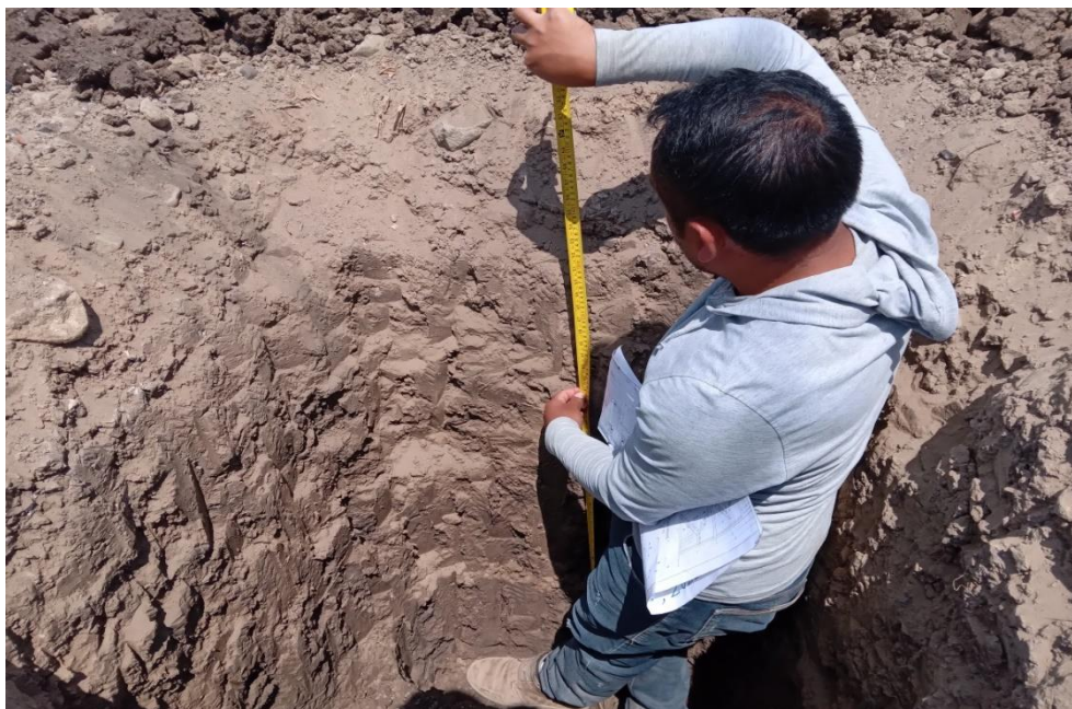
Fotografía 17 Verificación de calicata 5.
