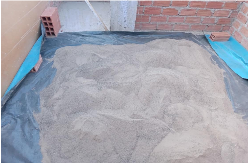
Fotografía 29 Tamizado del material extraído.
