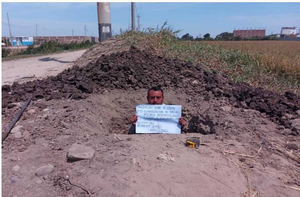
Fotografía 16 Verificación de la calicata 4.
