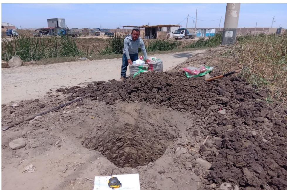
Fotografía 18 Muestras extraídas de la Calicata 5.
