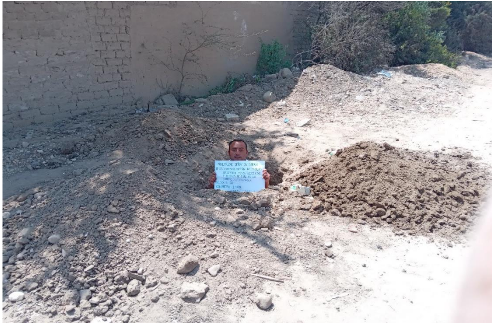
Fotografía 7 Verificación de la calicata 1
