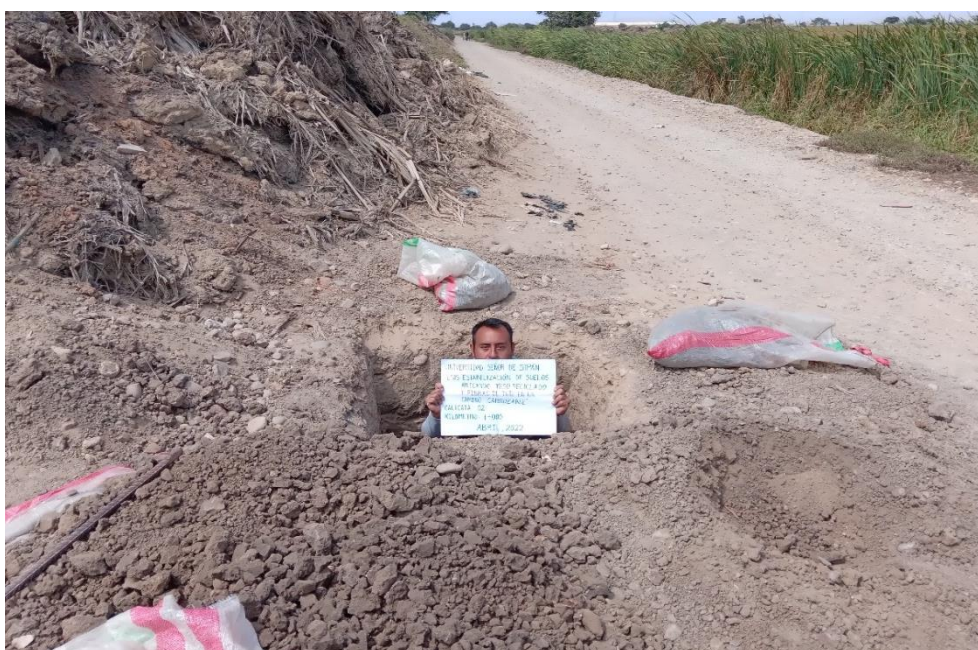
Fotografía 10 Verificación de la calicata 2.
