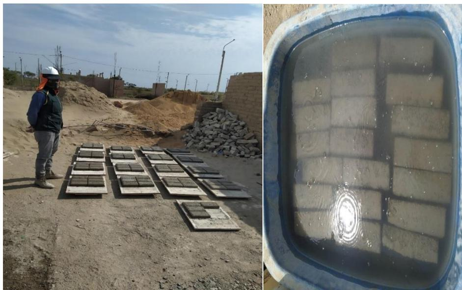
**Ilustración 10:** Proceso de secado y curado de los adoquines de concreto
