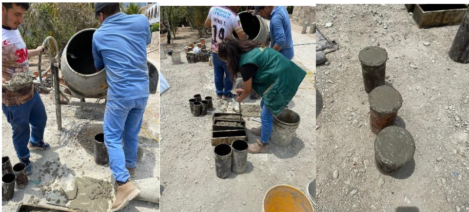
Ilustración 31: Realización de mezcla de Concreto Patrón
