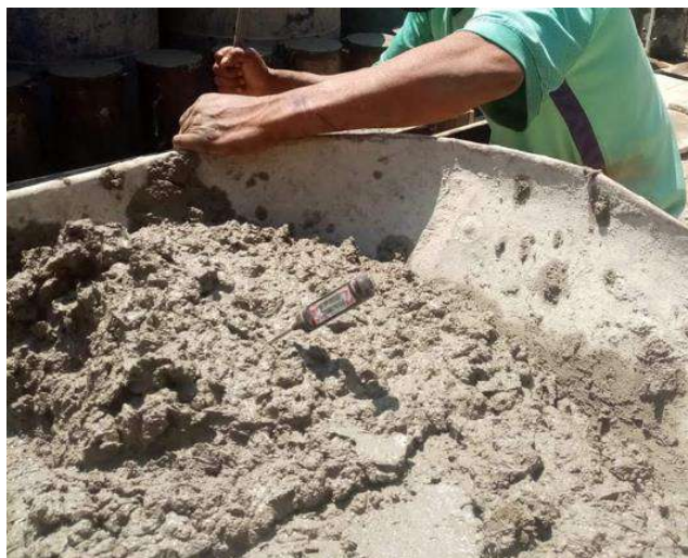
Fig. 14 Medición de la Temperatura del concreto.
