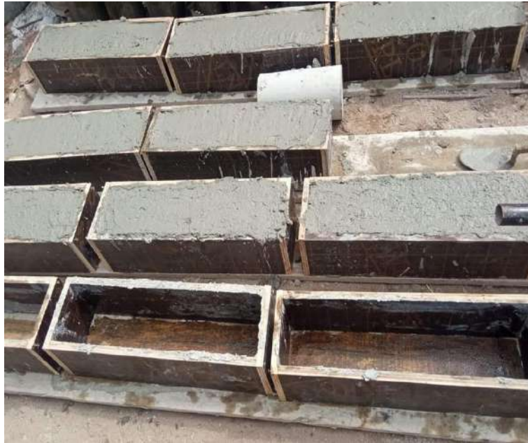
Fotografía 14. Vaciado de moldes rectangulares para ensayos de flexión.
