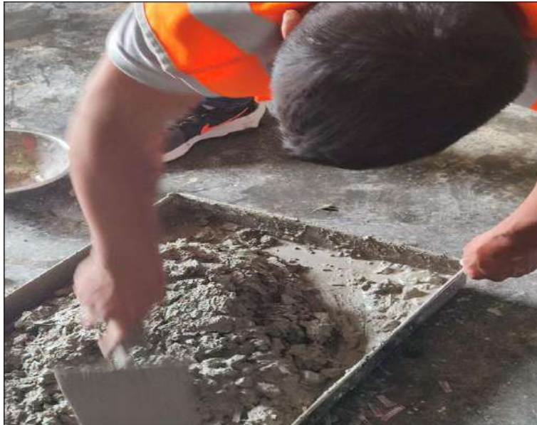
Fotografía 8. Elaboración de la mezcla del concreto patrón
