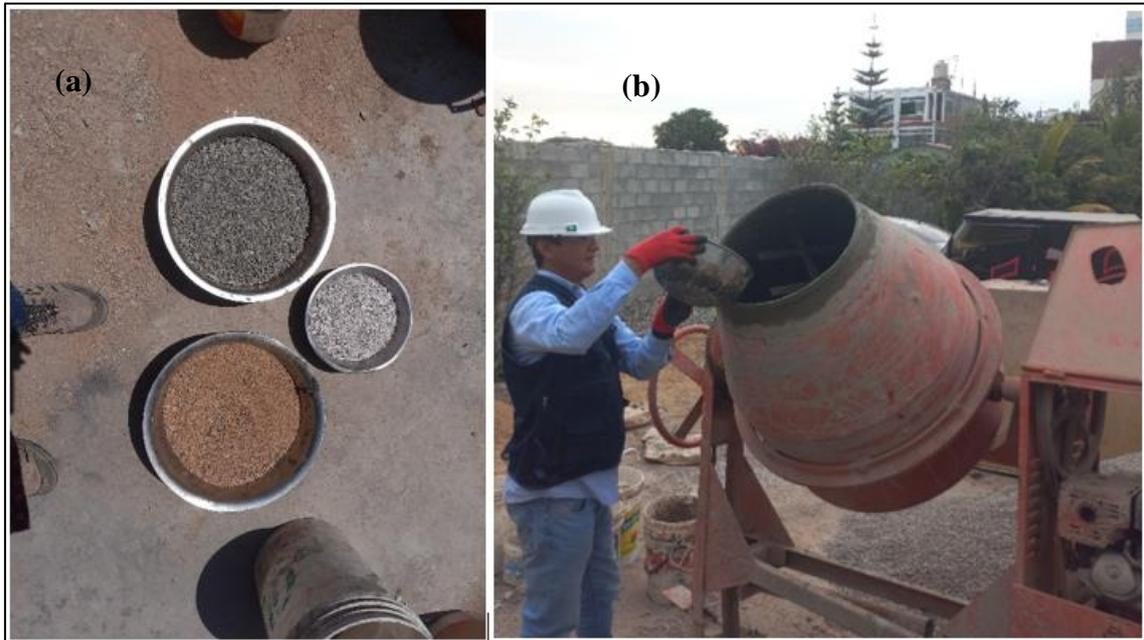
**Fig. 25.** Preparación de mezcla para adoquines. (a) Agregados: arena, confitillo y CA, (b) Incorporación de CA a mezcladora.
