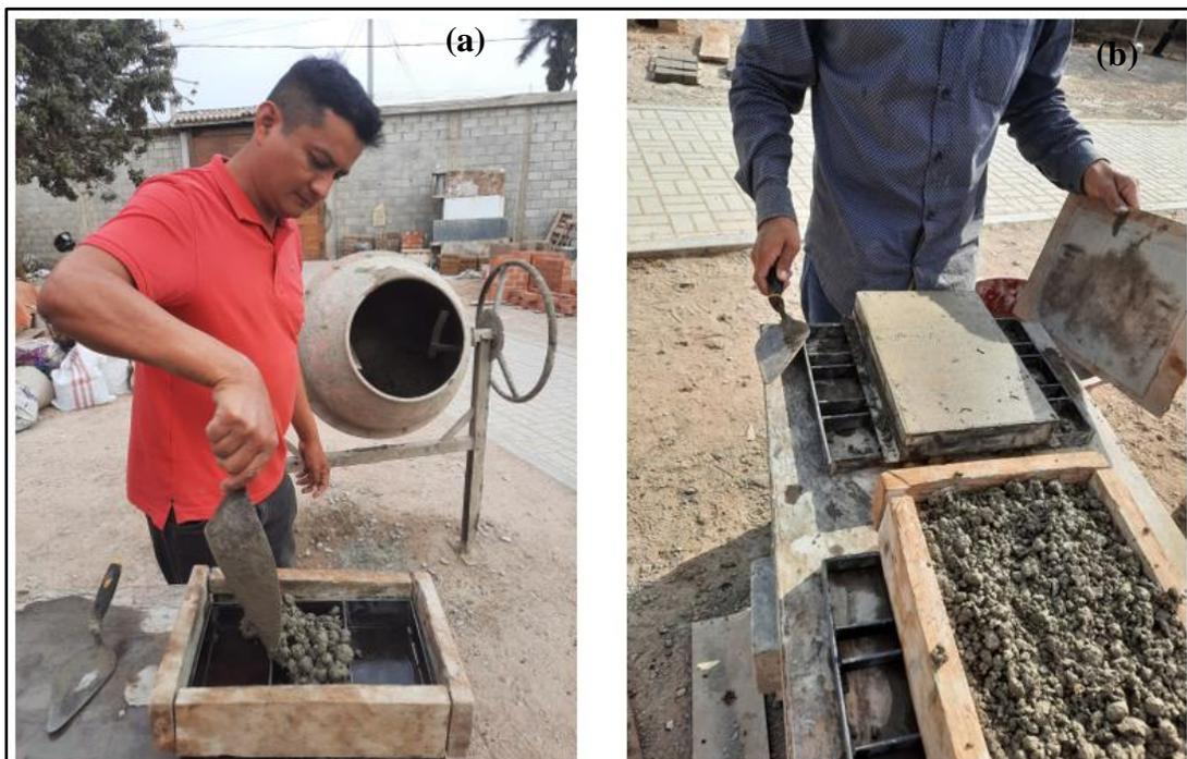
**Fig. 26.** Moldeado de adoquines de CA. (a) Incorporación a molde, (b) Acabado de aduquín.
