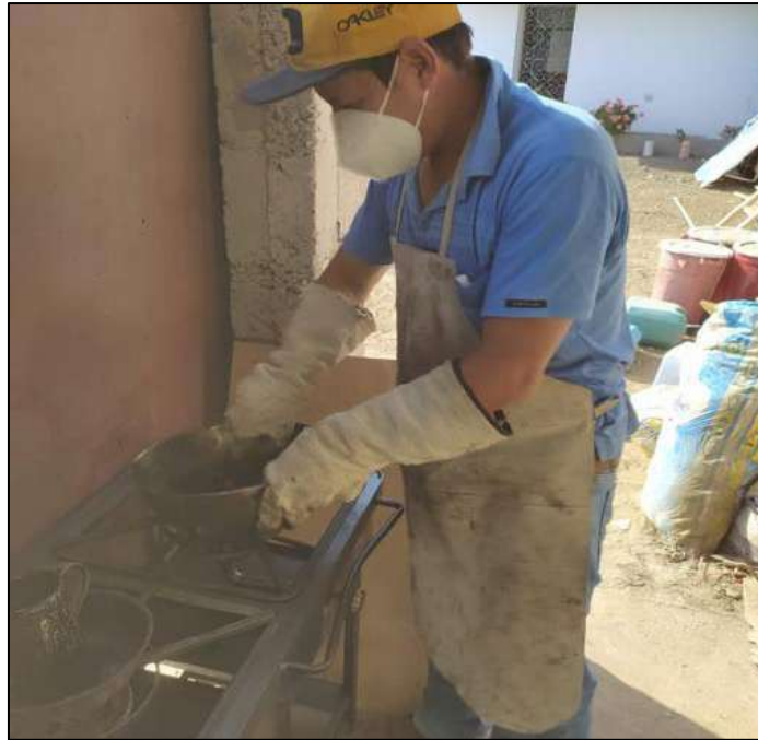
Fig. 16. Elaboración de la mezcla asfáltica en caliente.
