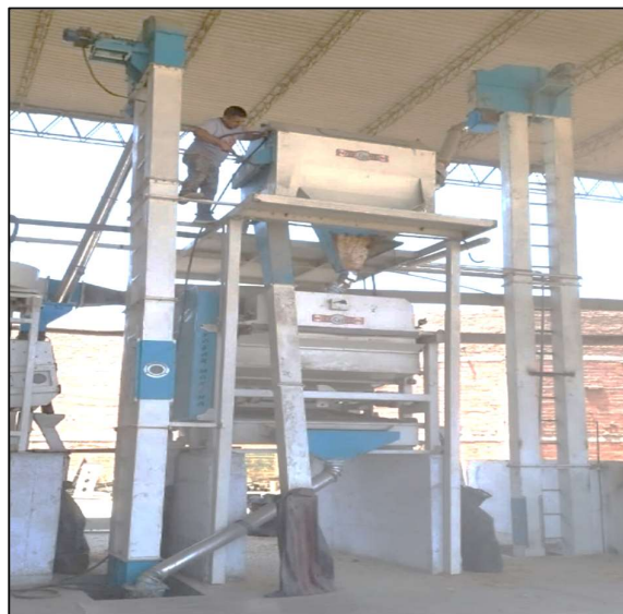
Figura 31. Evidencia del mantenimiento de las máquinas / equipos.
