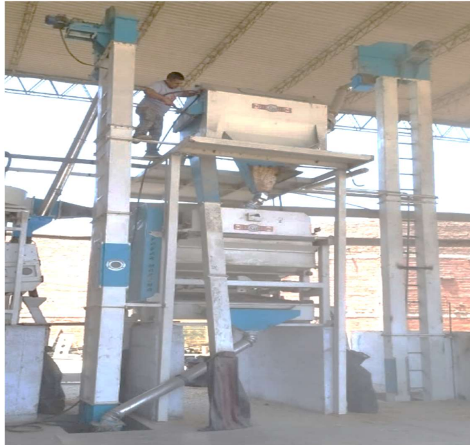
Figura 61. Evidencia 1 del mantenimiento de las máquinas y equipos.
