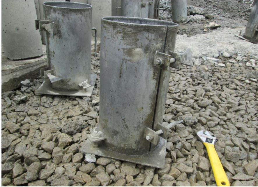
Fig. 45. Preparación de moldes para vaciado de testigos.
