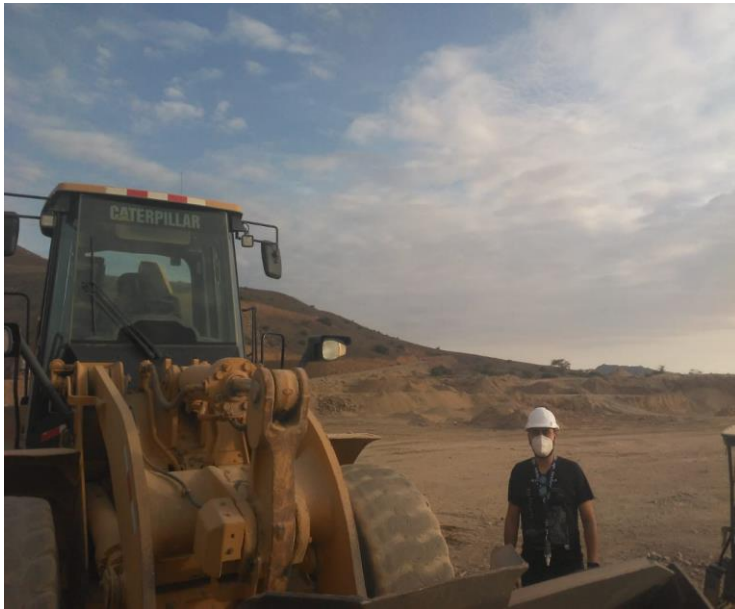
Fig. 9. Uso de maquinaria pesada para la explotación de agregados.
