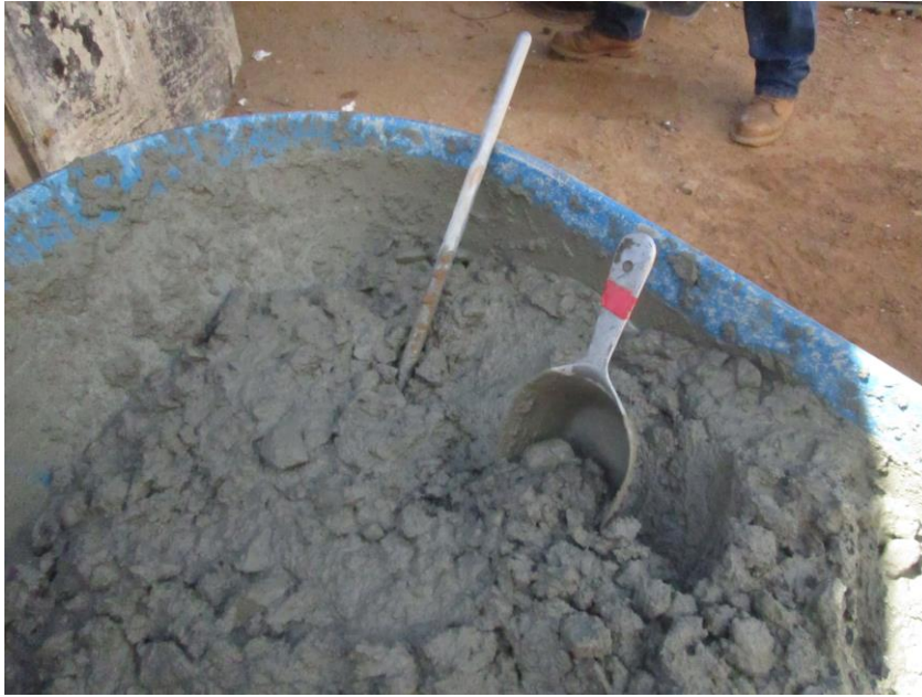
Fig. 43. Mezcla de concreto para elaboración de especímenes.
