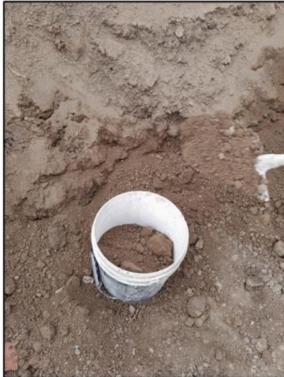
**Fig. 17.** Selección de tierra arcillosa para la fabricación de adobes
