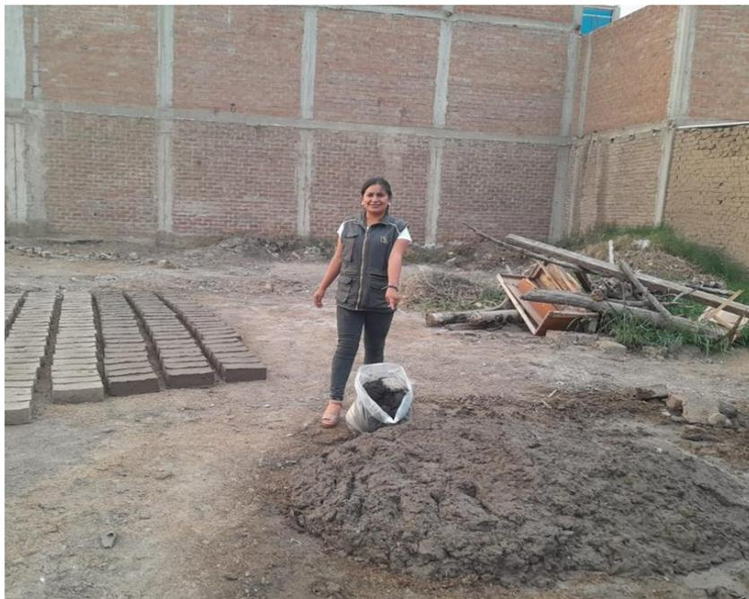
**Fig. 20.** Reposo de la mezcla para el adobe convencional
