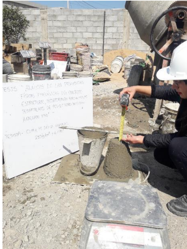
Ensayo de asentamiento o slump.
