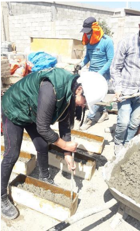
Moldeo de vigas y probetas de concreto.
