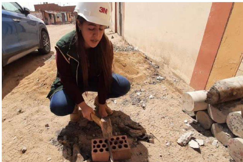
Corte de unidad para ensayo a compresión axial
