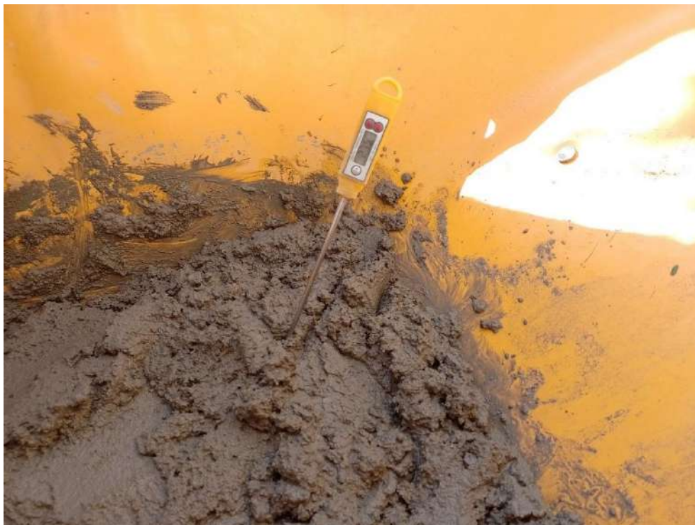
Temperatura del mortero
