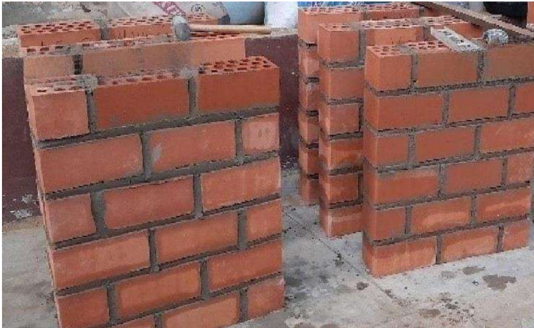
Elaboración de muretes de albañilería.
