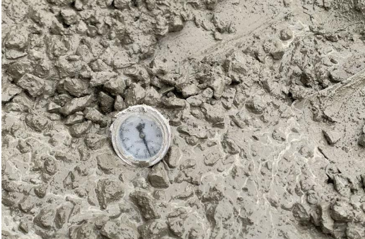
Fig. 35. Medición de la temperatura del concreto fresco.
