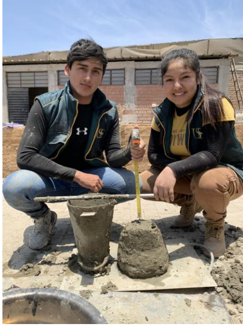
Fig. 34. Medición del Slump del concreto fresco.
