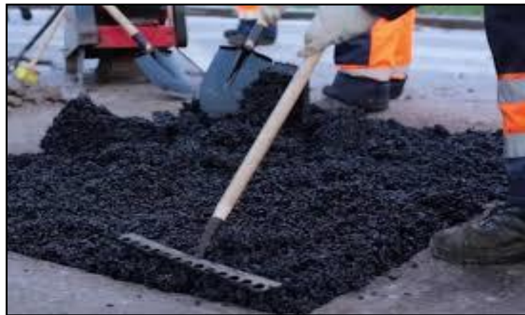
Figura 2. Trabajos de bacheo con mezcla asfáltica
