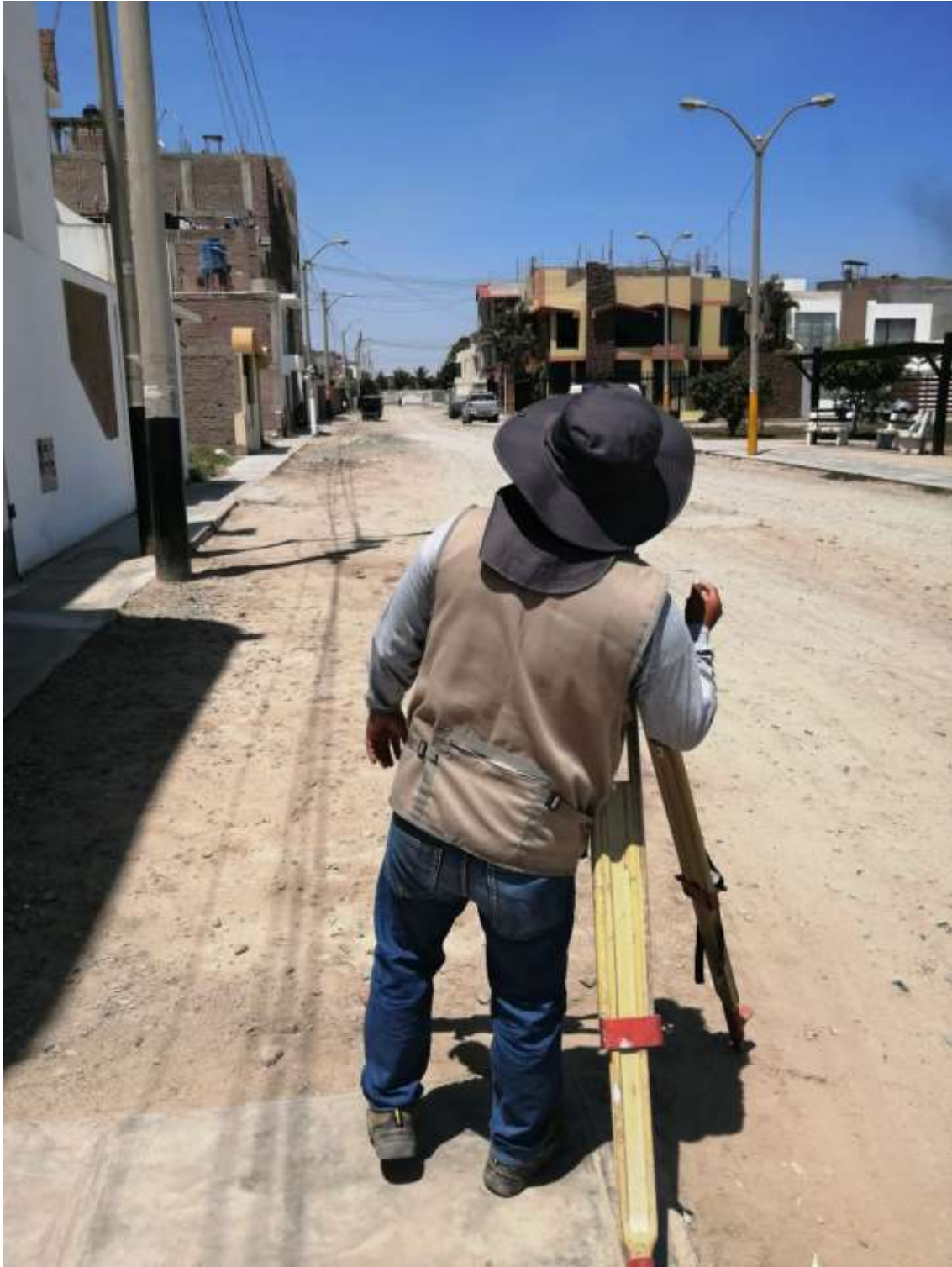
Fig. 19. Toma de puntos topográficos - calle Bosque de Pómac.
