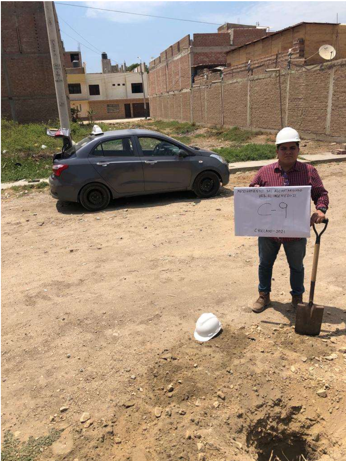
Fig. 25. Excavación de calicata 01 en calle Coloniales de Zaña.
