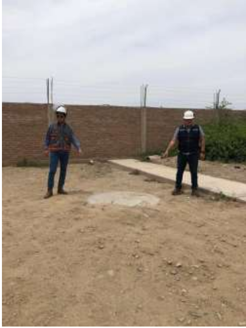
Fig. 14. Buzón que colapsa N° 01.
