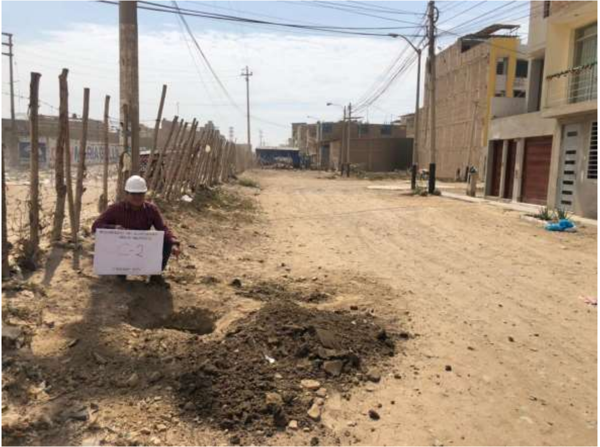
Fig. 23. Excavación de calicata 02 en prolongación Lora y Lora.
