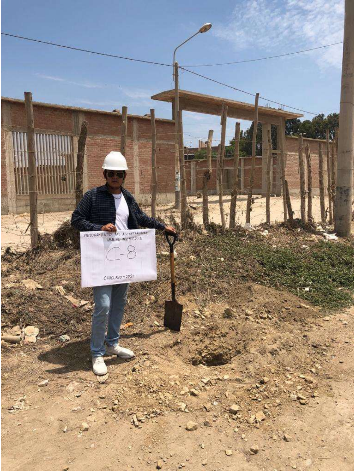
Fig. 24. Excavación de calicata 08 en prolongación Lora y Lora.
