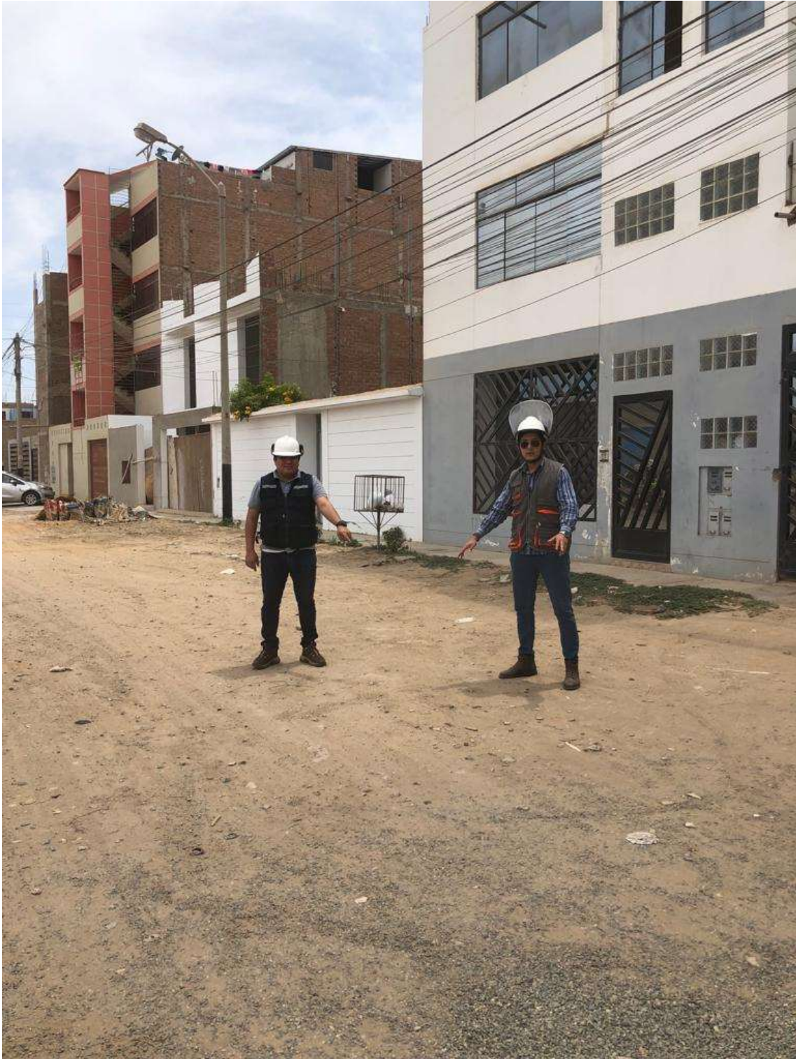
Fig. 28. Muestra de buzón faltante en el actual sistema de alcantarillado.
