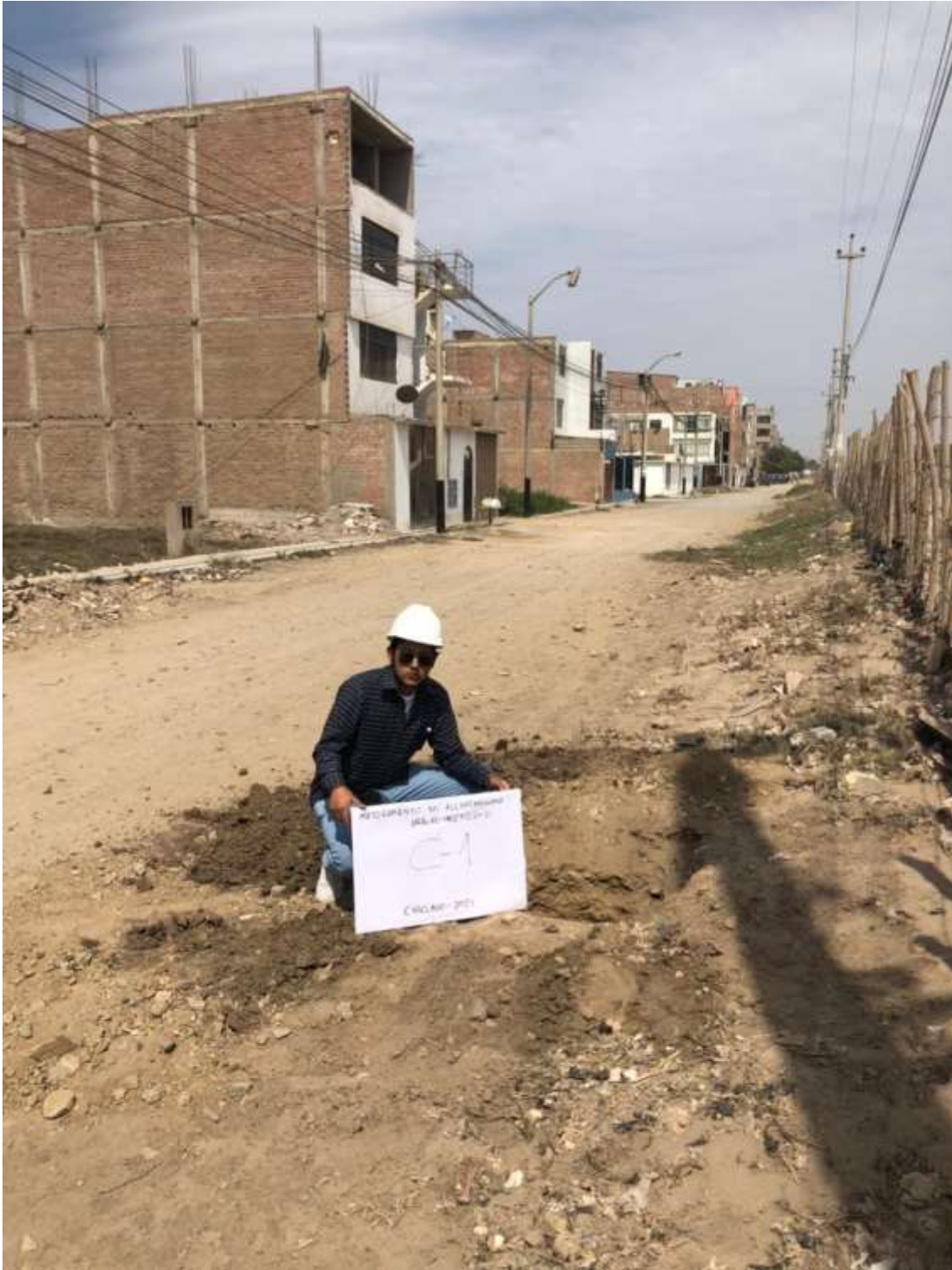
Fig. 22. Excavación de calicata 01 en prolongación Lora y Lora.
