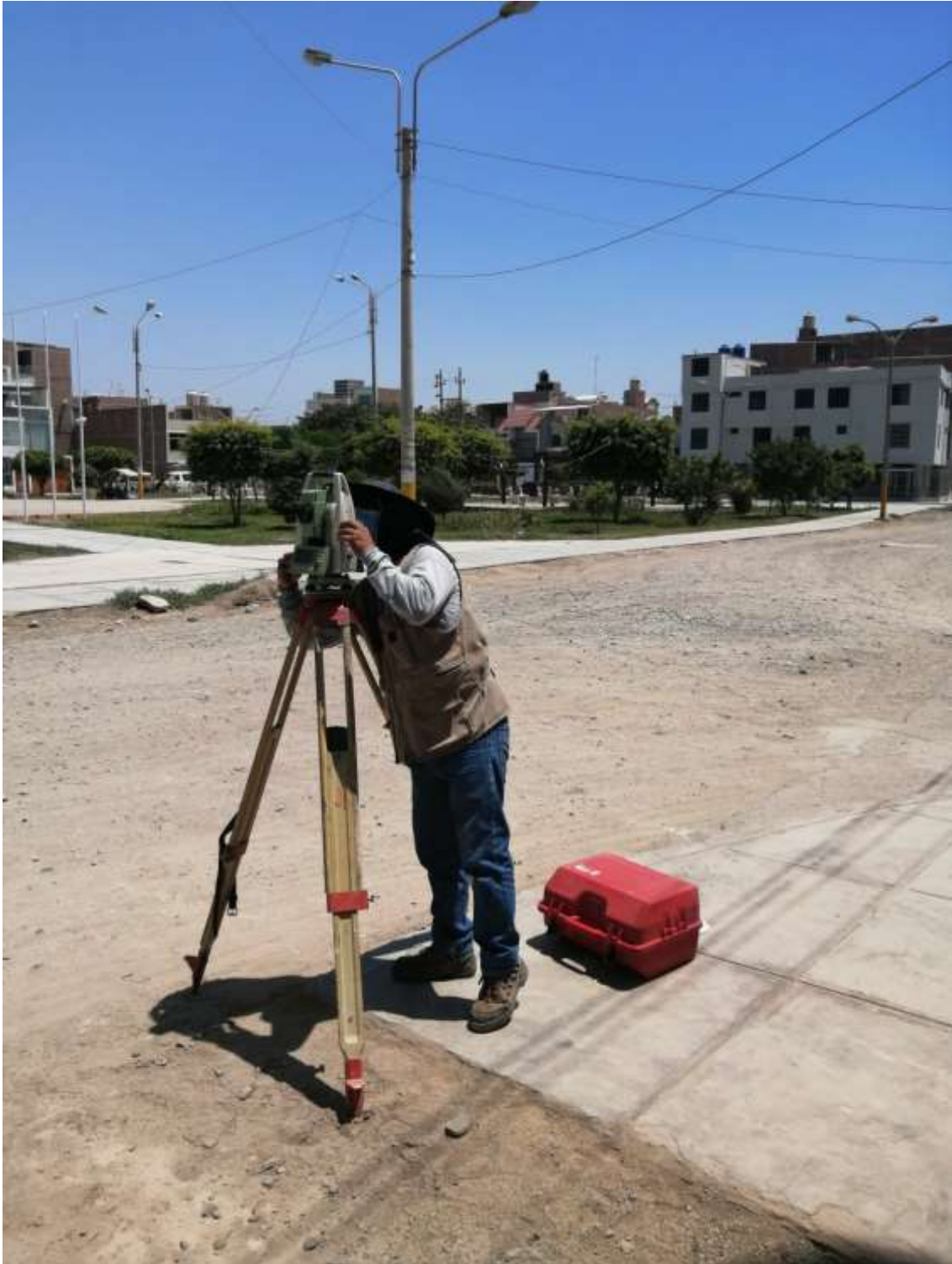
Fig. 20. Toma de puntos topográficos - calle Llampayec.
