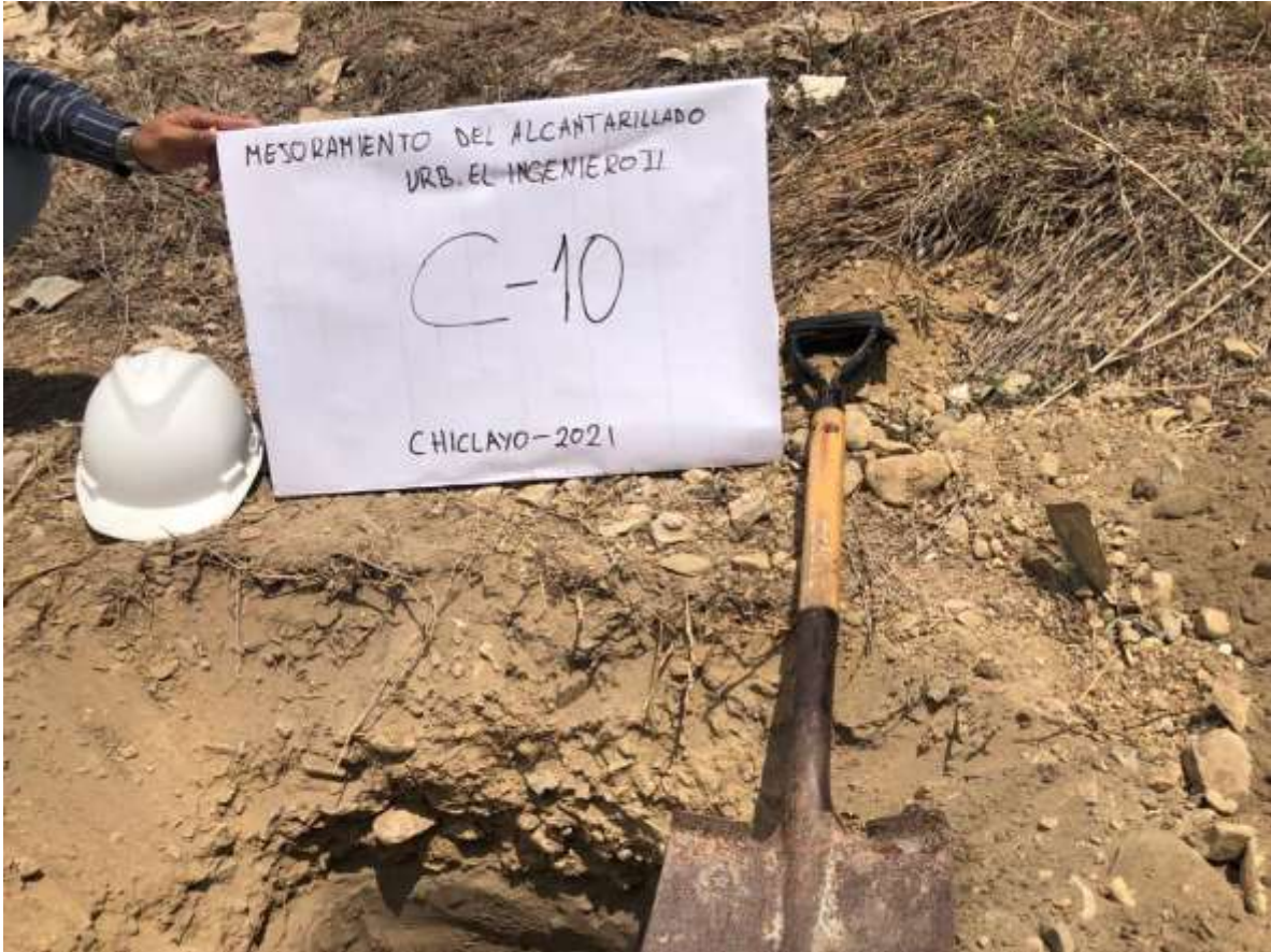
Fig. 26. Excavación de calicata 01 en calle Bosque de Pómac.
