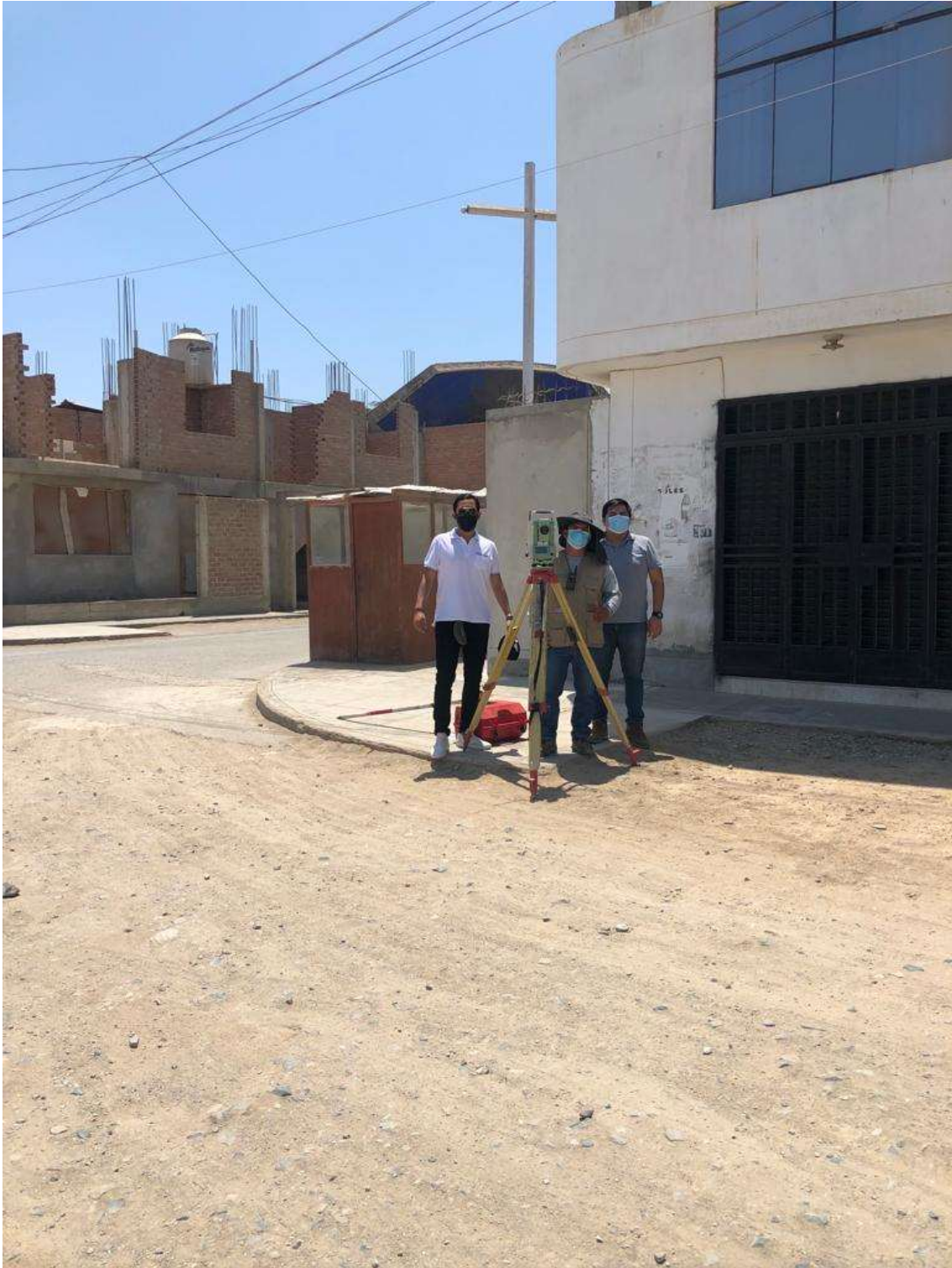
Fig. 21. Supervisión de los tesisistas durante el levantamiento topográfico.
