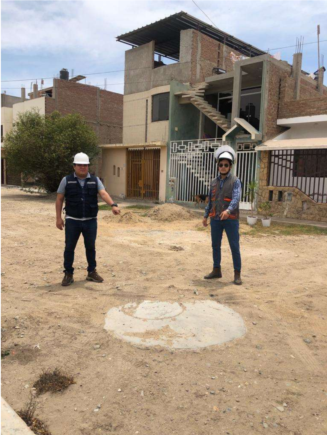
Fig. 27. Evaluación de los puntos críticos del actual sistema de alcantarillado.
