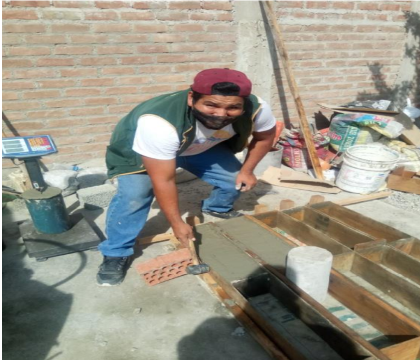
Foto 25 Vaciado de concreto en vigas
