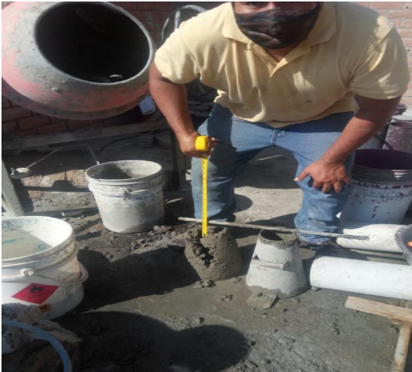
Foto 23 Ensayo de asentamiento de la mezcla
