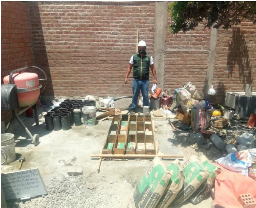
Foto 24 Elaboración de las probetas cilíndricas y vigas
