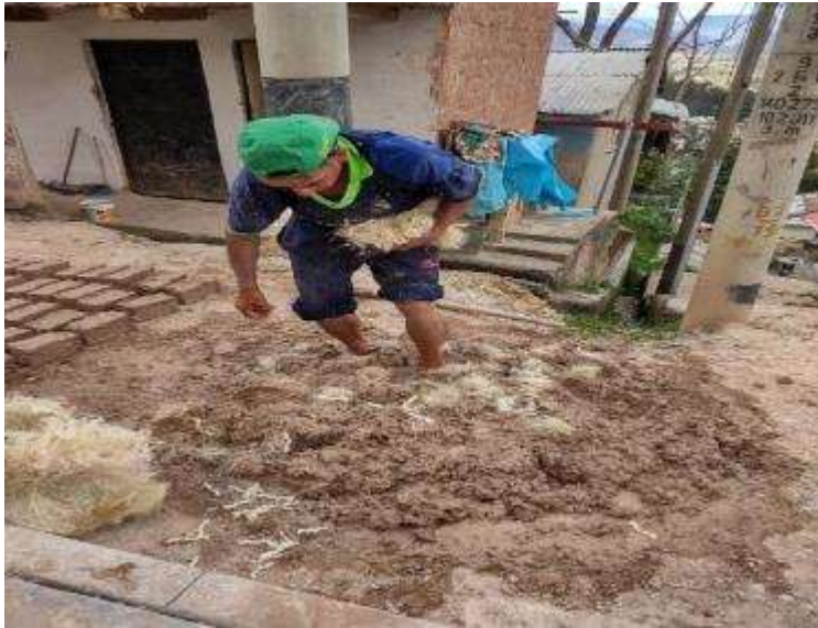
Fig. 32. Amasado respectivo del material.
