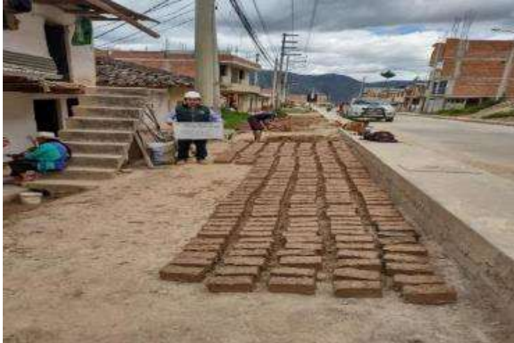
Fig. 34. Secado respectivo de los adobes.
