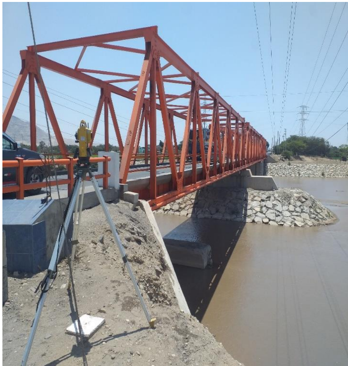
LEVANTAMIENTO TOPOGRAFICO EMPLEANDO ESTACION TOTAL
