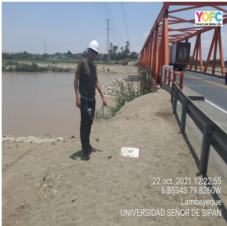
IDENTIFICACION DE LOS PUNTOS DE CONTROL PARA EL INICIO DEL LEVANTAMIENTO TOPOGRAFICO AGUAS ARRIBA
