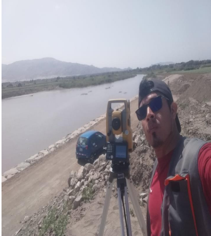
LEVANTAMIENTO TOPOGRAFICO EMPLEANDO ESTACION TOTAL
