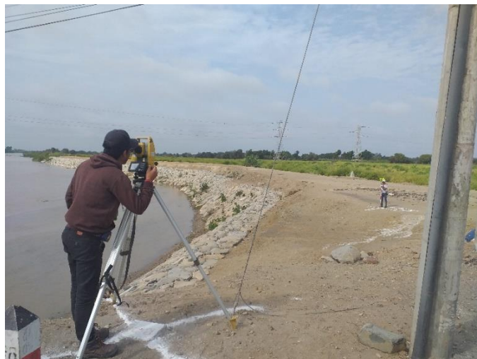
Fig. 18. Tramo Aguas Abajo. Nota. Levantamiento Aguas Debajo con Estación Total.
