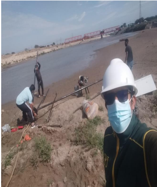
REALIZACION DE LA CALICATA N° 01
