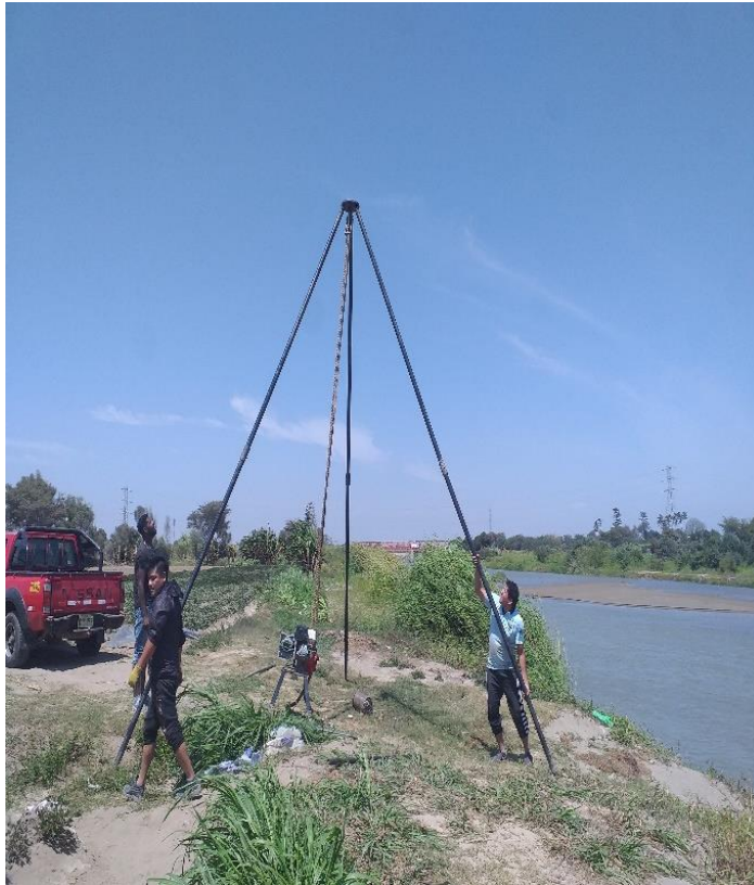
REALIZACION DE LA CALICATA N° 04
