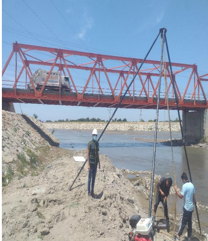
REALIZACION DE LA CALICATA N° 02
