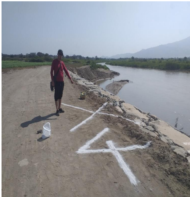
COLOCACION DE PUNTOS FOTOCONTROL PARA EL LEVANTAMIENTO FOTOGAMETRICO
