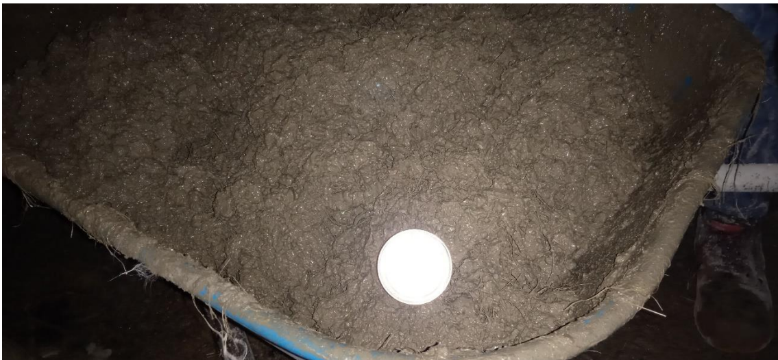
Fotografía 02. Se visualiza la mezcla de concreto por tanda.
