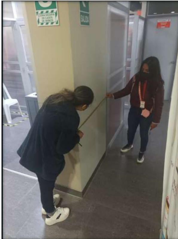
Toma de medida de muro estructural
