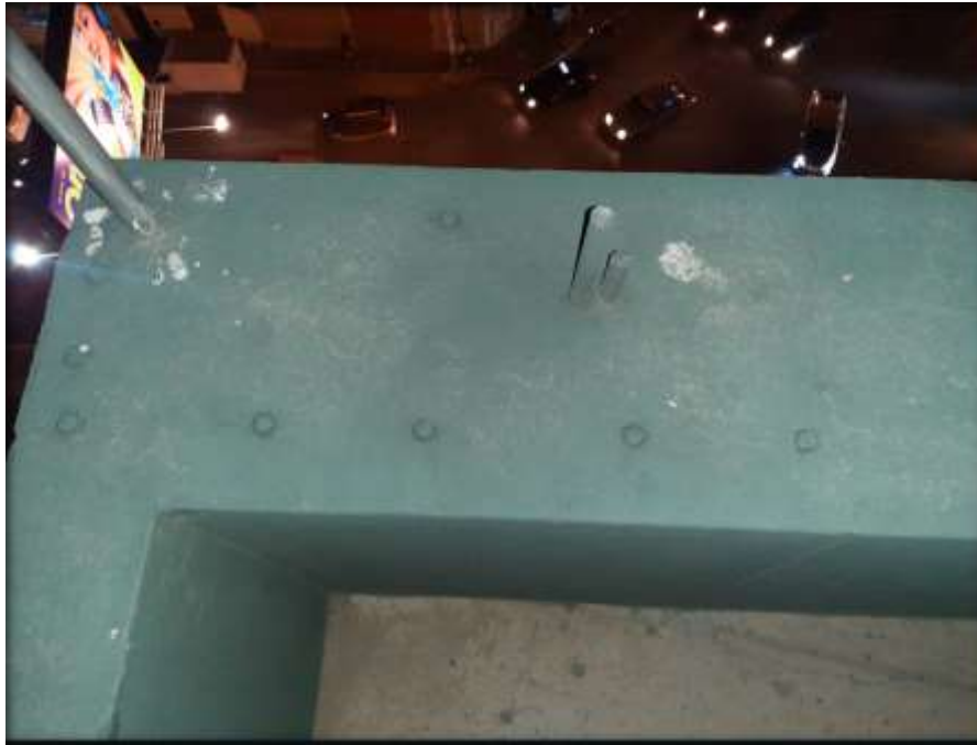
Mechas finales de muro portante en azotea
