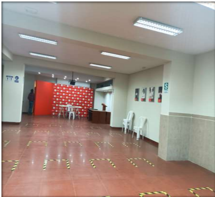
columnas y pinto de vigas en semi sótano
