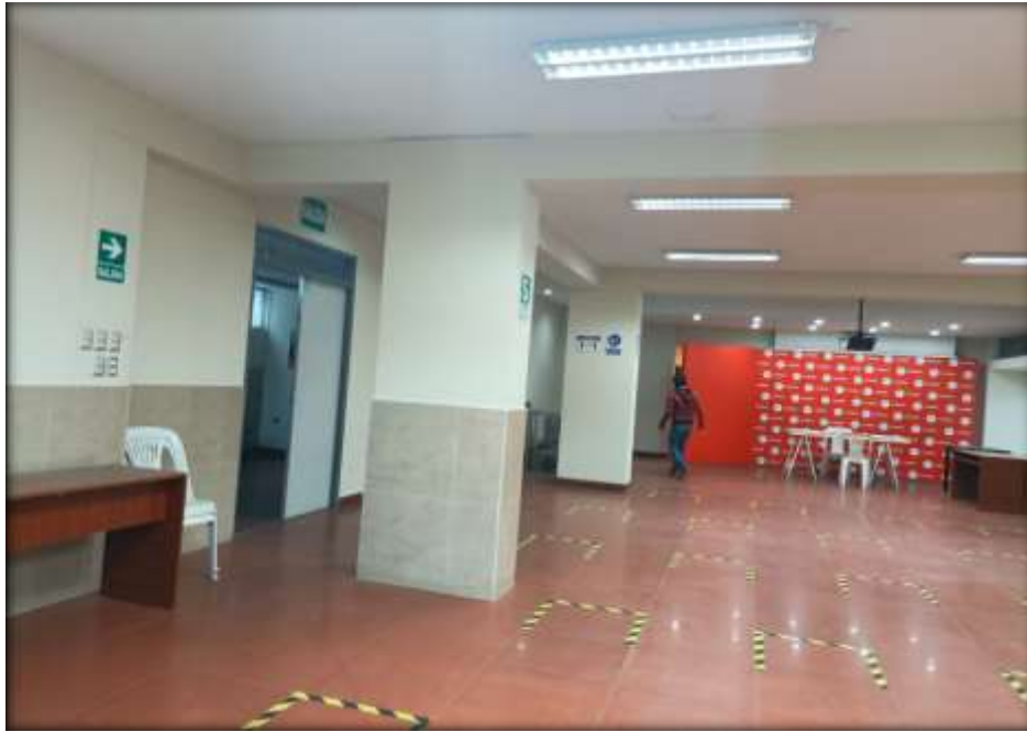
Columnas y pinto de vigas en semi sótano
