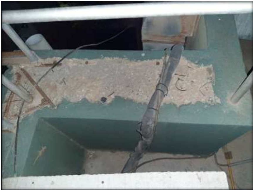
Cabecera de muro estructural
