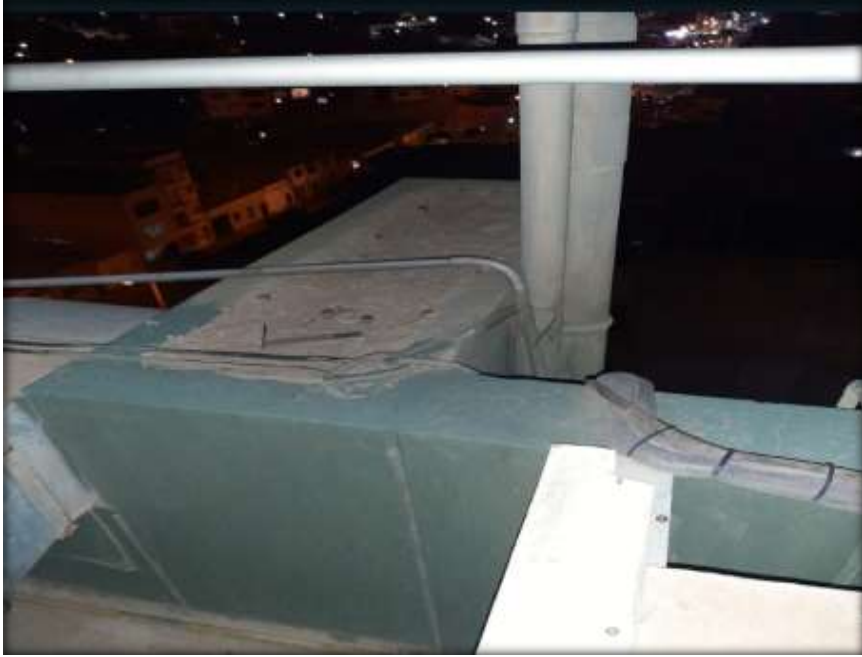
Cabecera de muro estructural
