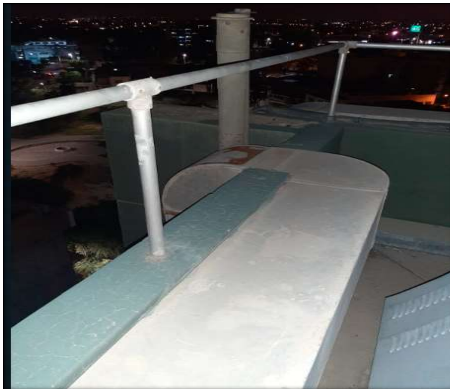
Al fondo se observa la cúspide del muro estructural
