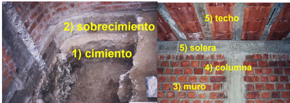
Fig. 6. Composición del sistema de albañilería confinada. [39]
