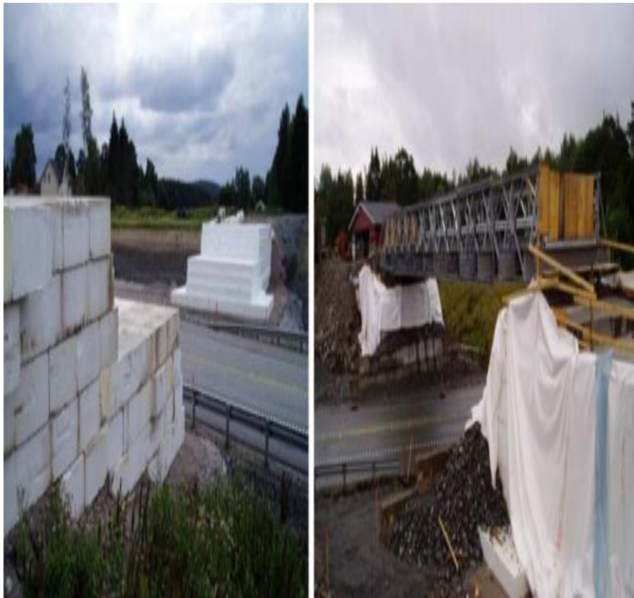
Fig. 14. PE como estribo de puente en la construcción del puente Grimsvyegen, Noruega. [41]
