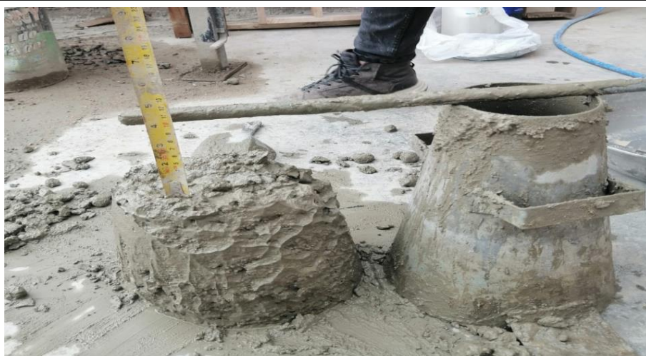
Fig. 29. Medición del Asentamiento.
