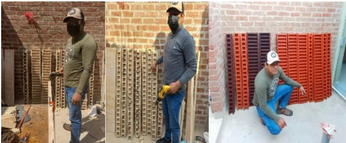
Confección de moldes (cubos y vigas).
