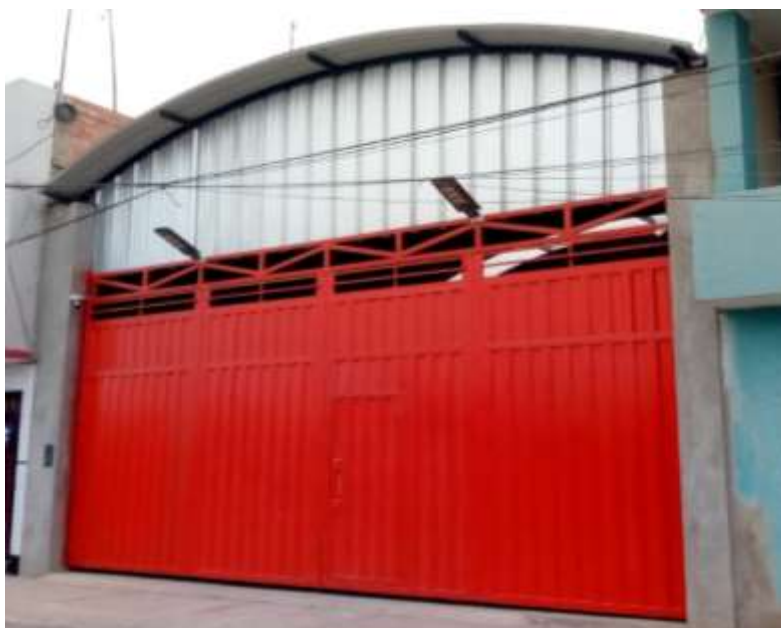
Almacén con cámaras de seguridad
