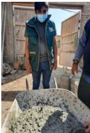
Figura 21. Medición de temperatura del concreto.
