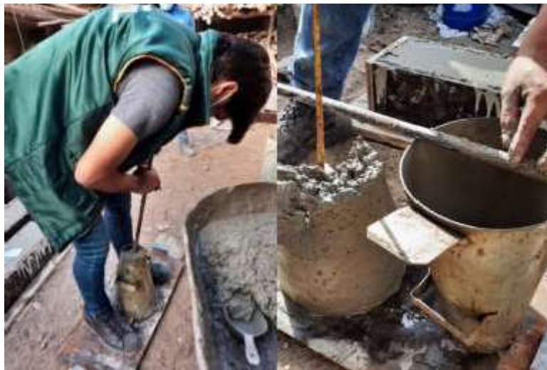
Figura 20. Medición del asentamiento con el cono de Abrams.
