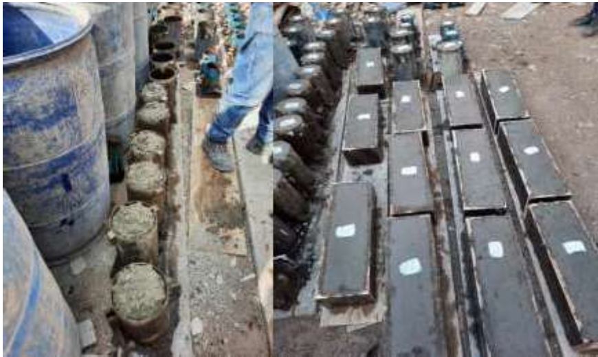
Figura 18. Realización de probetas y vigas.
