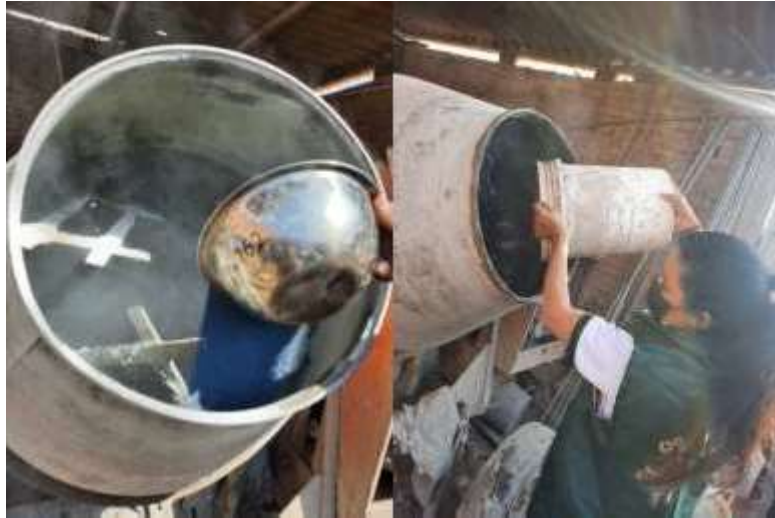
Figura 17. Incorporación de materiales reemplazantes a la mezcla de concreto.
