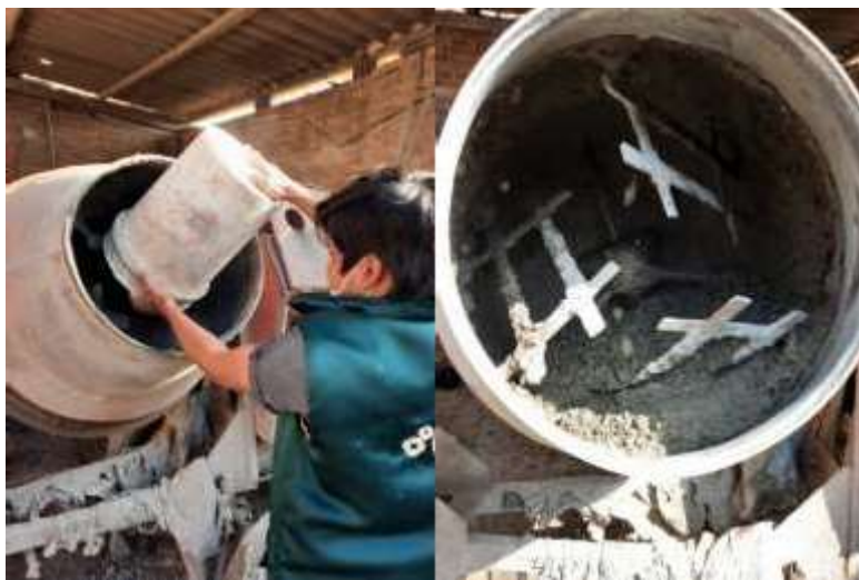
Figura 15. Elaboración de mezcla de concreto.
