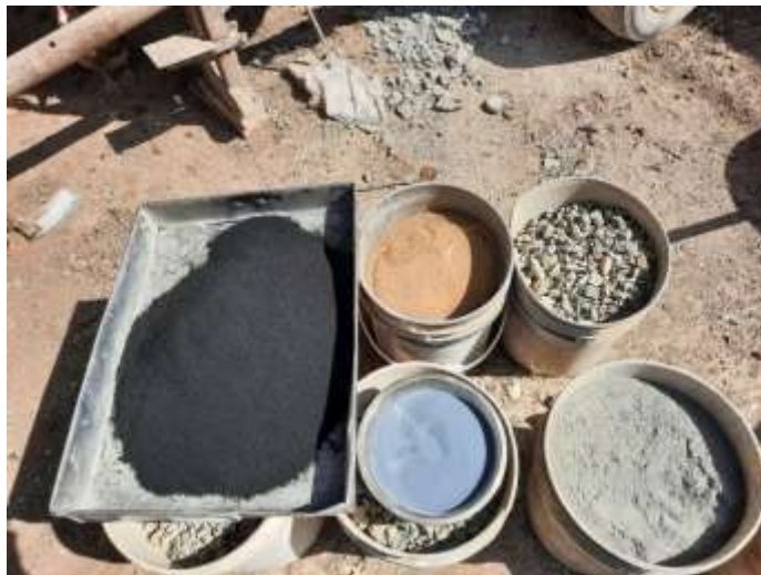
Figura 16. Pesado de materiales para la preparación de la mezcla de concreto.
