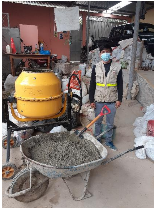
ELABORACION DE LA MEZCLA DE CONCRETO
