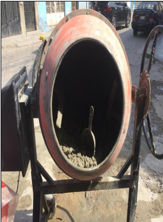
Ilustración 119. Preparación de la mezcla de concreto
