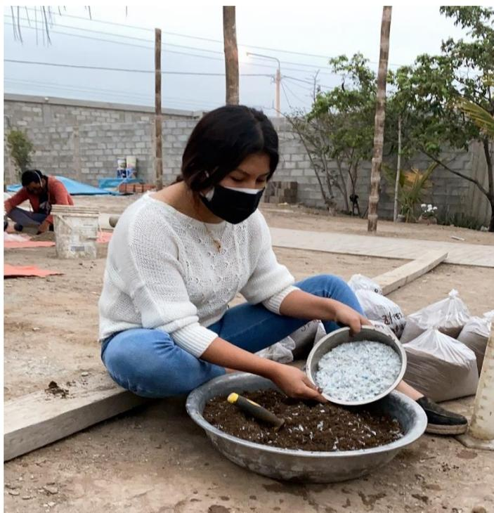
*Figura 126.* Mezcla de suelo y emulsión asfáltica.
