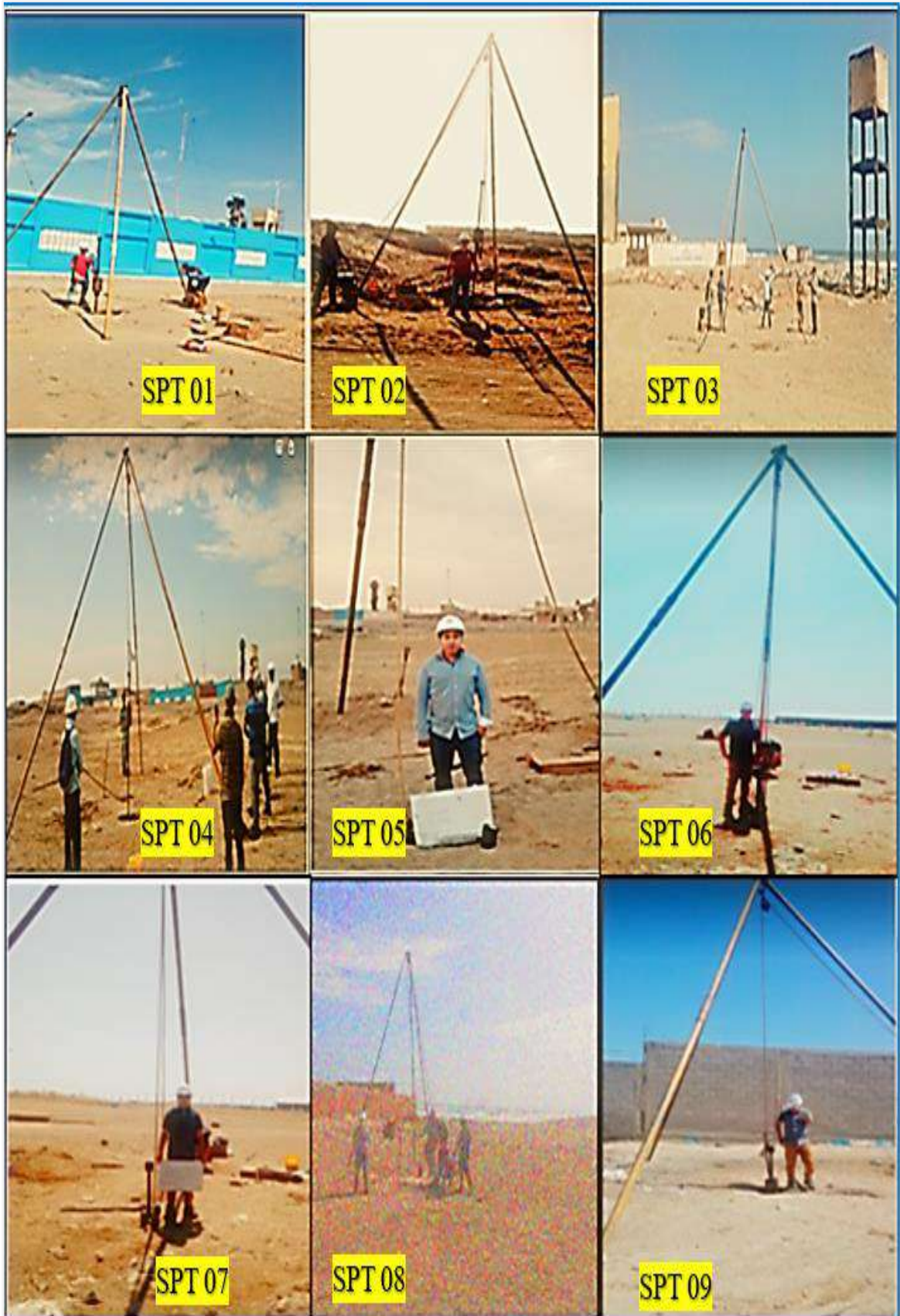
Figura 39. Ejecución de Ensayos de Penetración Estándar
