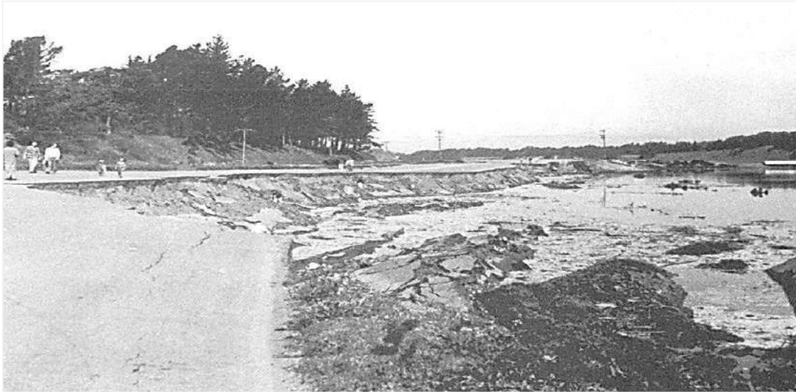
Figura 6. Falla del terreno por licuación de flujo ocurrida en el terraplén de una carretera en san francisco durante el terremoto de 1957 en Daly City
