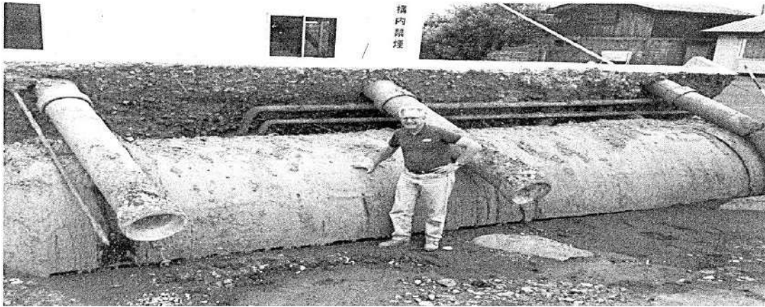
Figura 10. Expulsión y flotación de un tanque subterráneo por licuación de suelos Tomado de (Youd T. L., 2003)
