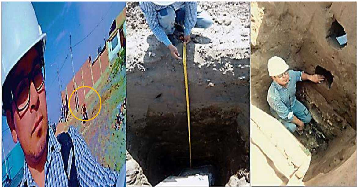
Figura 41. Ejecución de Calicatas a cielo abierto
