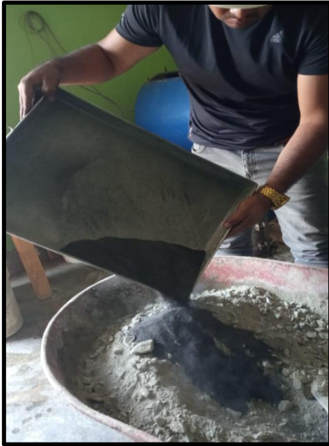
Foto 1: Adición de la ceniza en sustitución del cemento portland.
