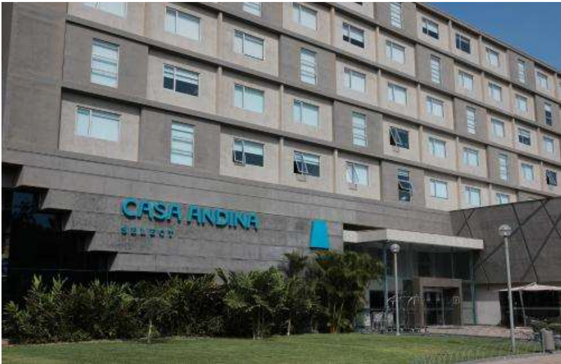
Figura 5: Empresa Consorcio Hotelero del Norte S.A. (Inquilino NESSUS HOTELES PERU S.A. (CASA ANDINA) Av. Federico Villarreal N°115
