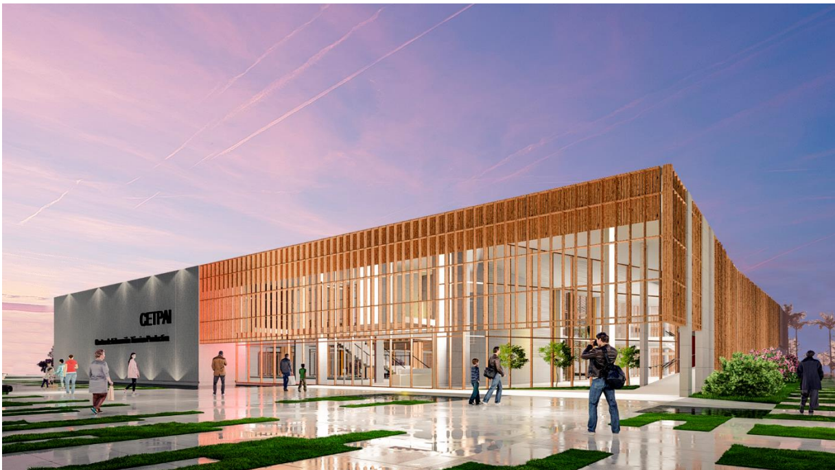
Figura n° 50: Vista del proyecto 02. Elaboración propia
