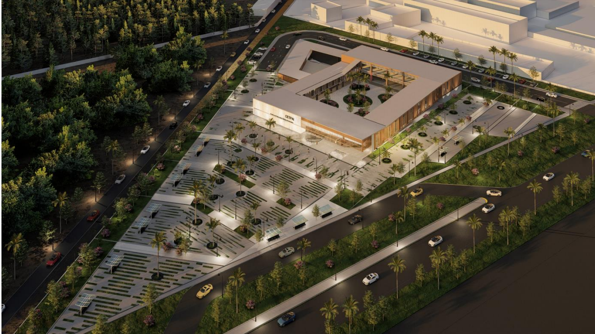
Figura n° 49: Vista del proyecto 01. Elaboración propia
